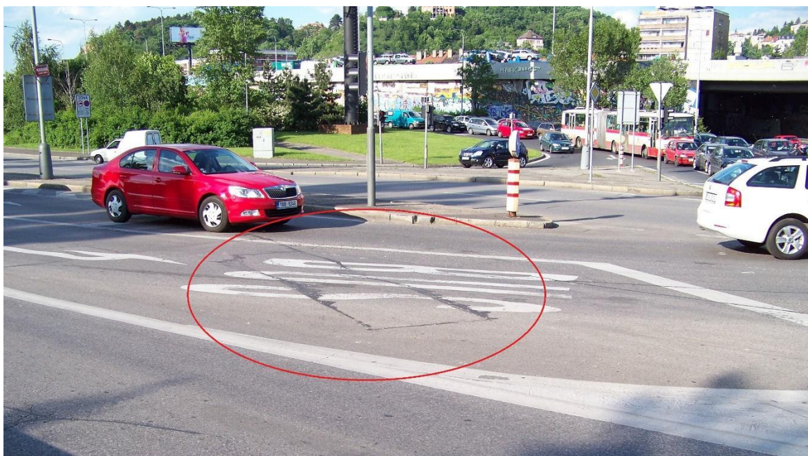
Obrázek 4: Umístění detekční smyčky, zakroužkováno červeně
