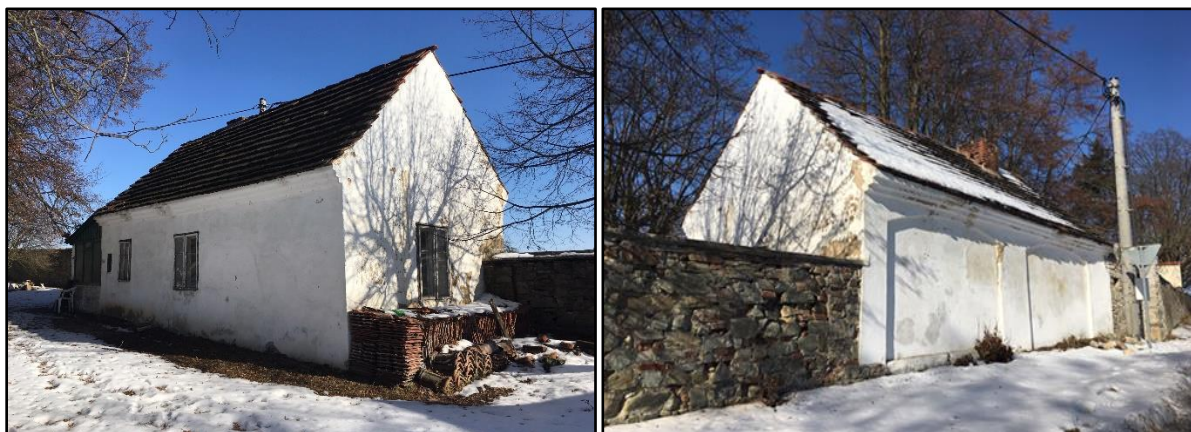
Obrázek 16 Správcovský domek – pohled jižní a východní
