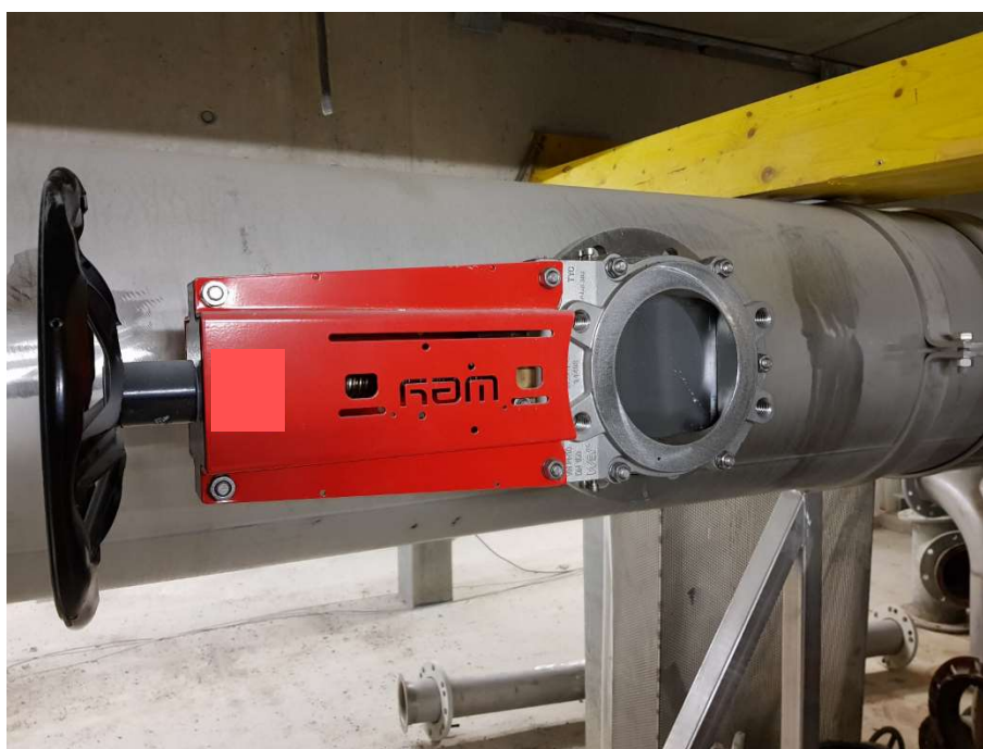
Obr. 7 Ručně ovládané nožové šoupátko [13]
