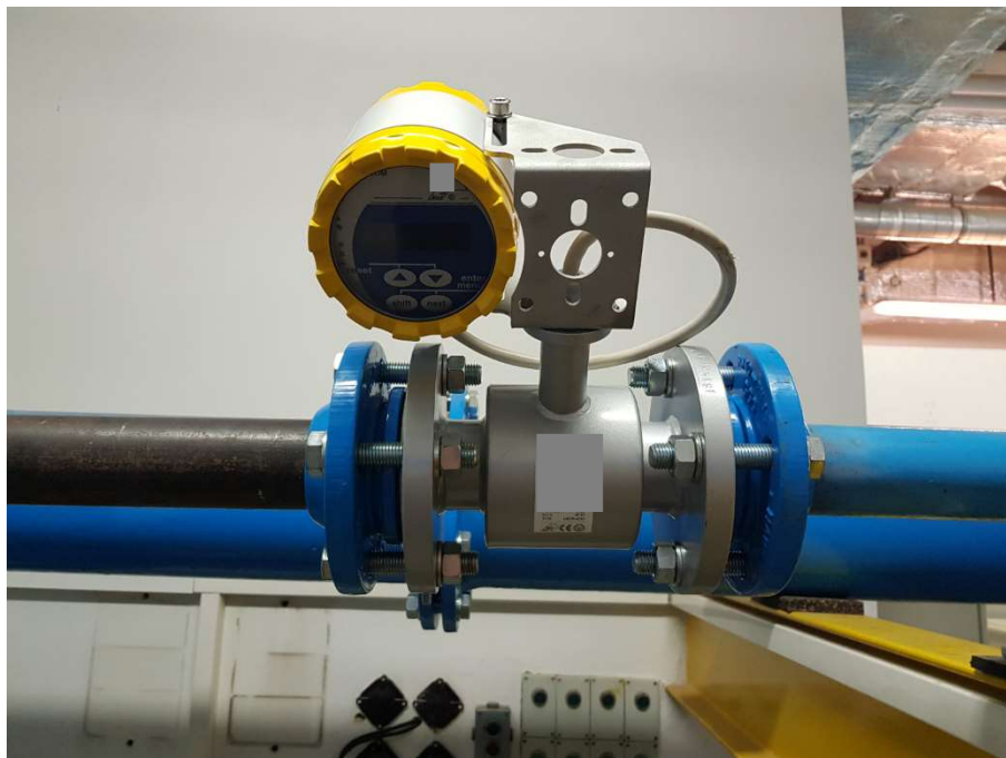
Obr. 6 Indukční průtokoměr v kompaktním provedení
