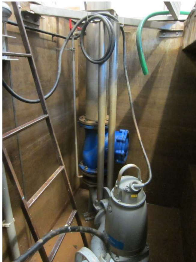
Obr. 5 Ponorné čerpadlo instalované na patkovém koleně pomocí spouštěcího zařízení
