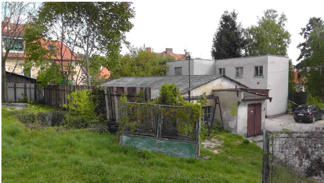
Obr. 1 Stávající stav dvou budov tvořící hydraulickou laboratoř
