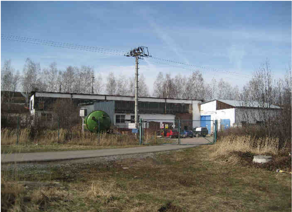
Příloha 8. Čistírna důlních vod Příbram I. Bytíz (foto: Eliška Pilecká, 2. 3. 2007)
