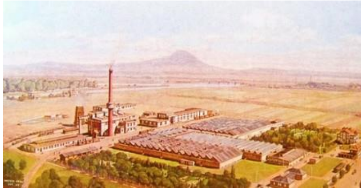
Obrázek 42: Továrna Glanzstoff Fabrik v Lovosicích
