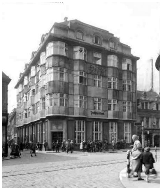
Obrázek 21: Budova bývalé eskomptní banky
