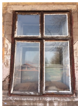
Obrázek č. 10. Špaletové okno. Zdroj: vlastní
