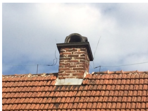
Obrázek č. 9. Komín doplněný kamennou hlavicí. Zdroj: vlastní
