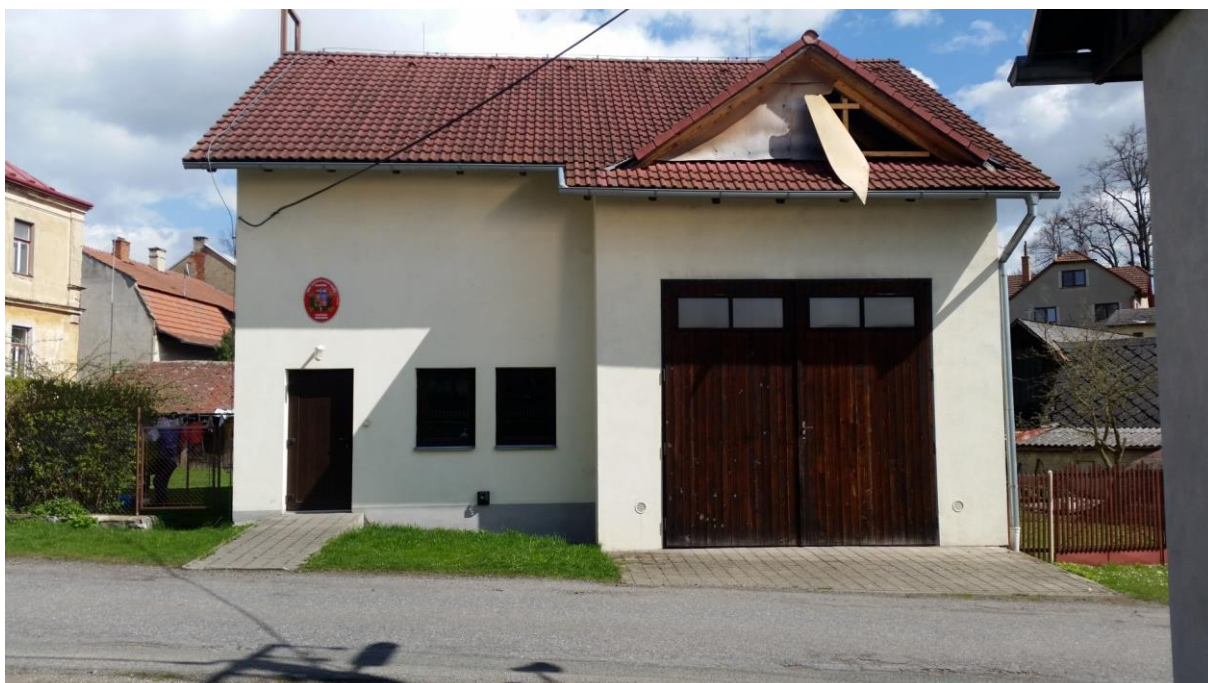
Obr. 32 Hasičská zbrojnice (Zdroj: MELEZÍNKOVÁ, 2017)
