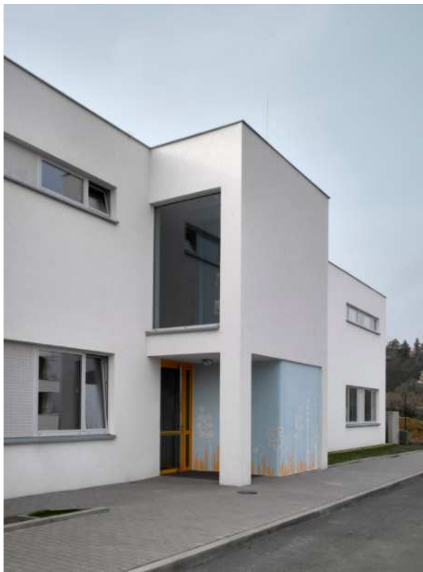
Obr. č. 29 Hlavní vstup do budovy školky
