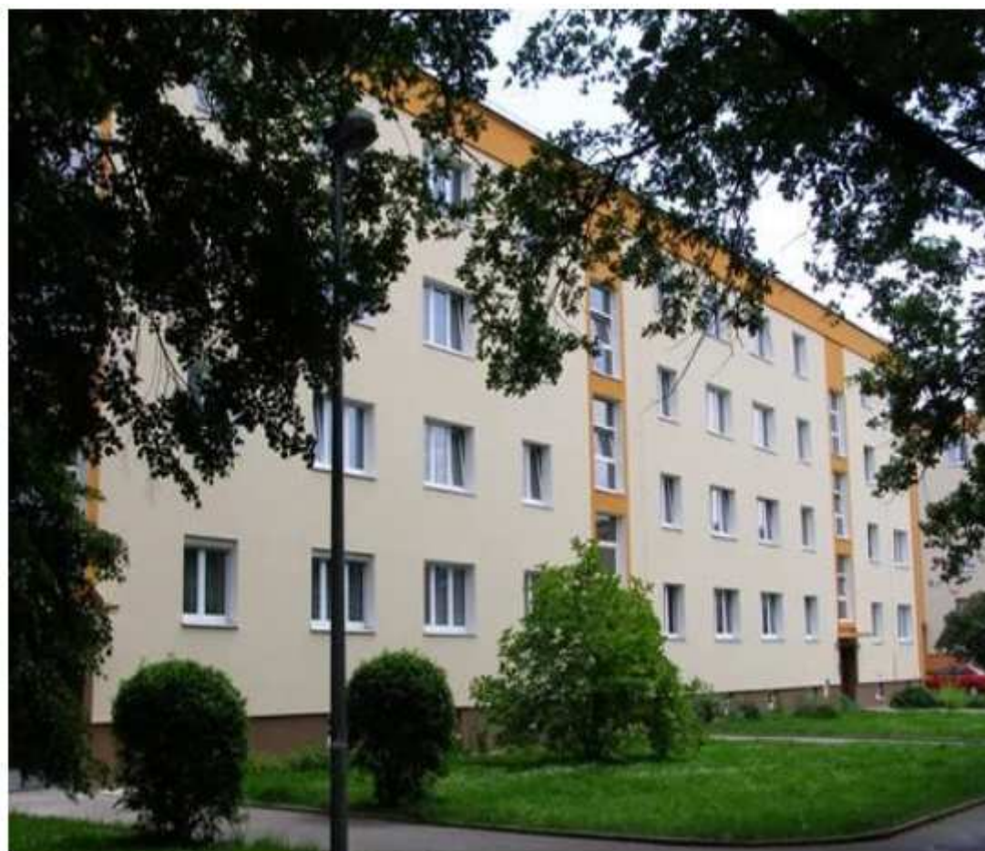
Obr. č. 11 Vlastní realizace panelového domu typu G57 [13]
