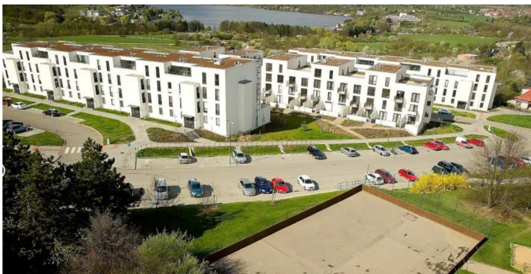
Obr. č. 24 Pohled na dokončenou etapu Panorama I.
