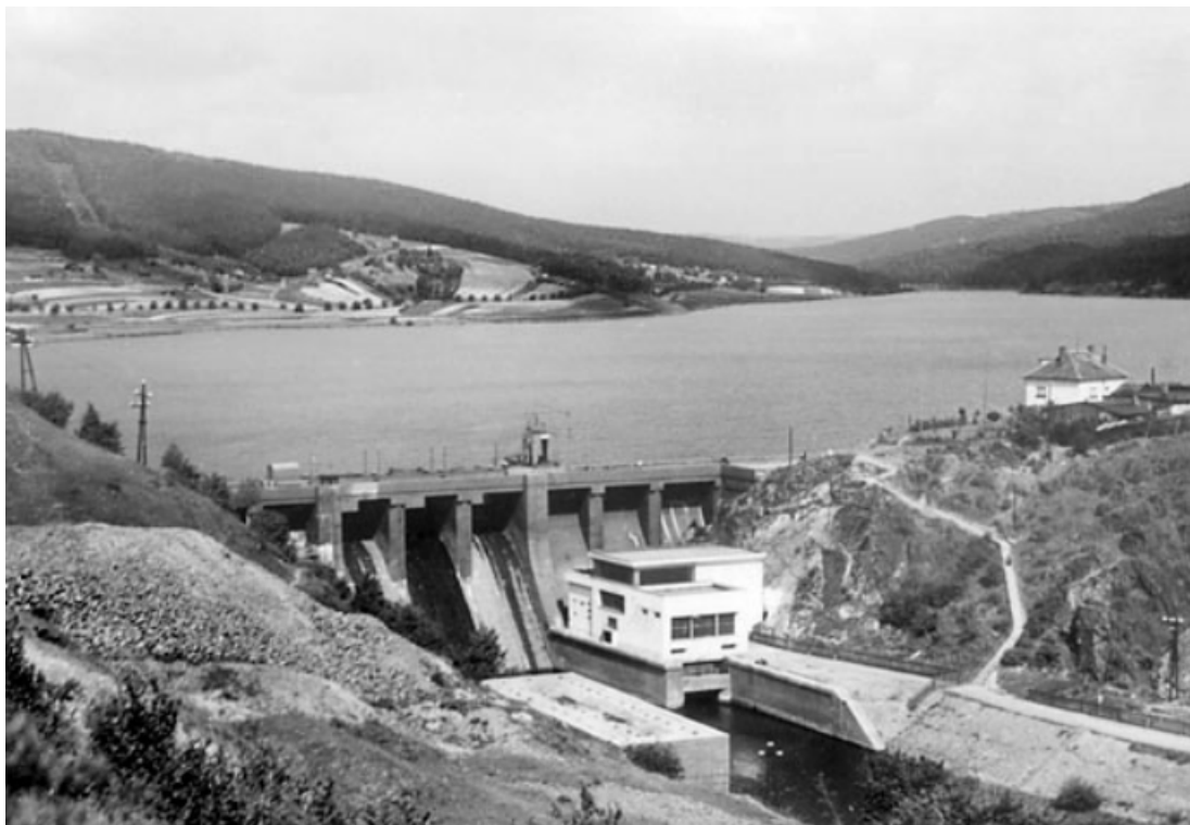
Obr. č. 8 Celkový pohled na hráz a přehradu (snímek z pohlednice pravděpodobně z roku 1949 [10])
