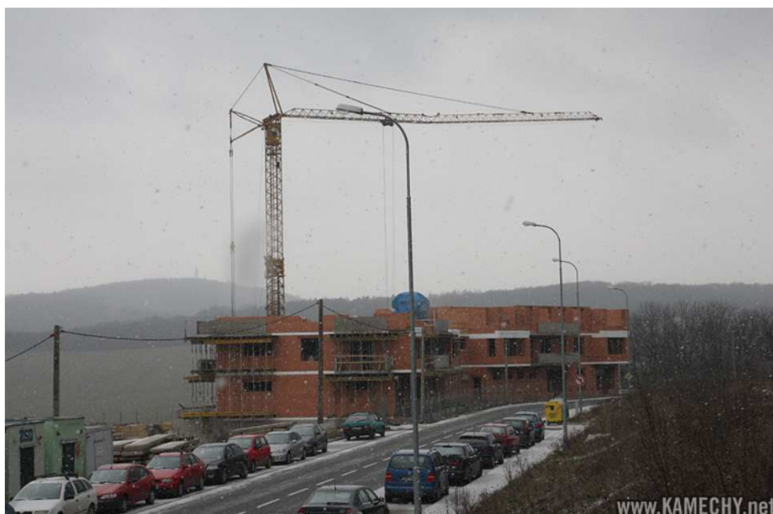
Obr. č. 22 Probíhající výstavba prvního bytového domu společností Reko a.s. [21]
