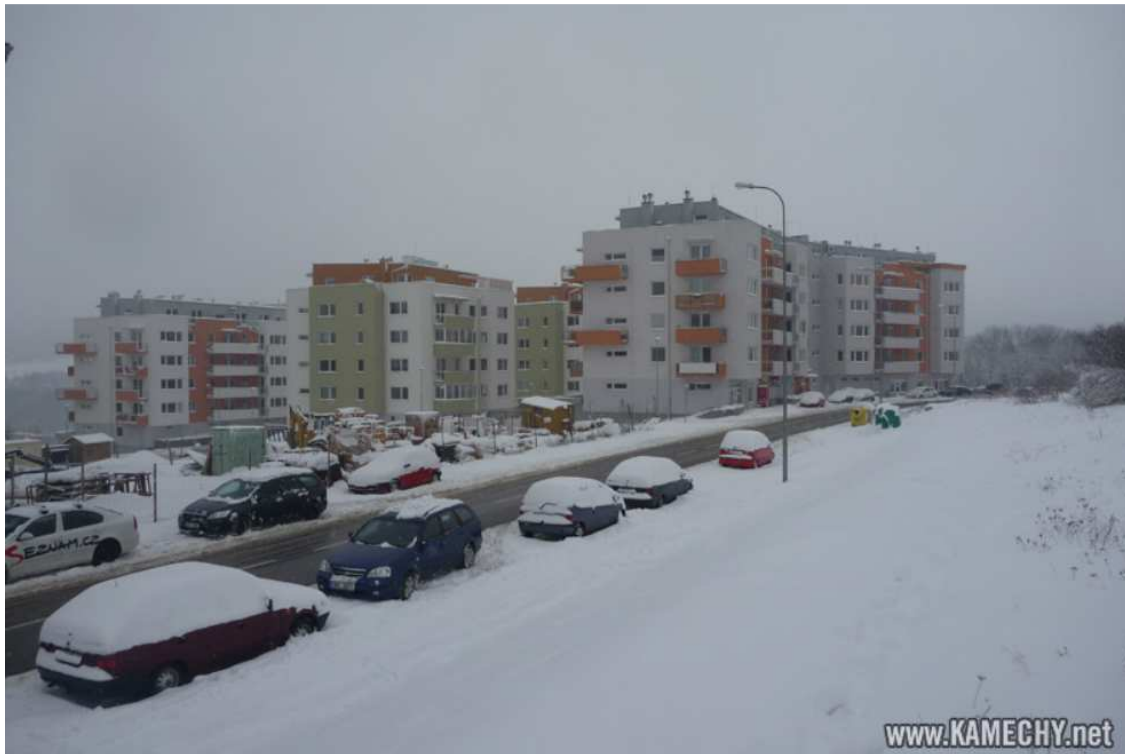
Obr. č. 23 Dokončená celková pod-etapová část ze zimy roku 2013 [21]
