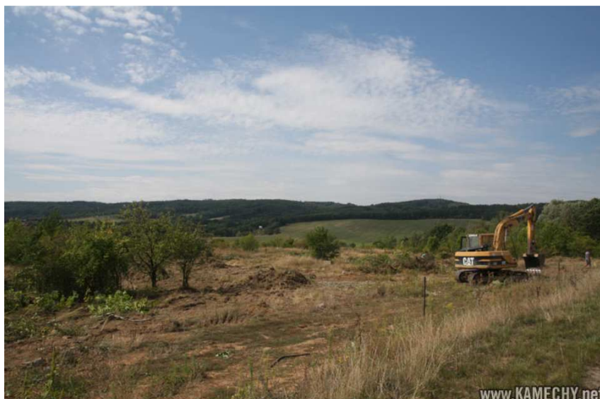
Obr. č. 21 První práce na pozemcích projektu Kamechy II., fotografie z roku 2008 [21]
