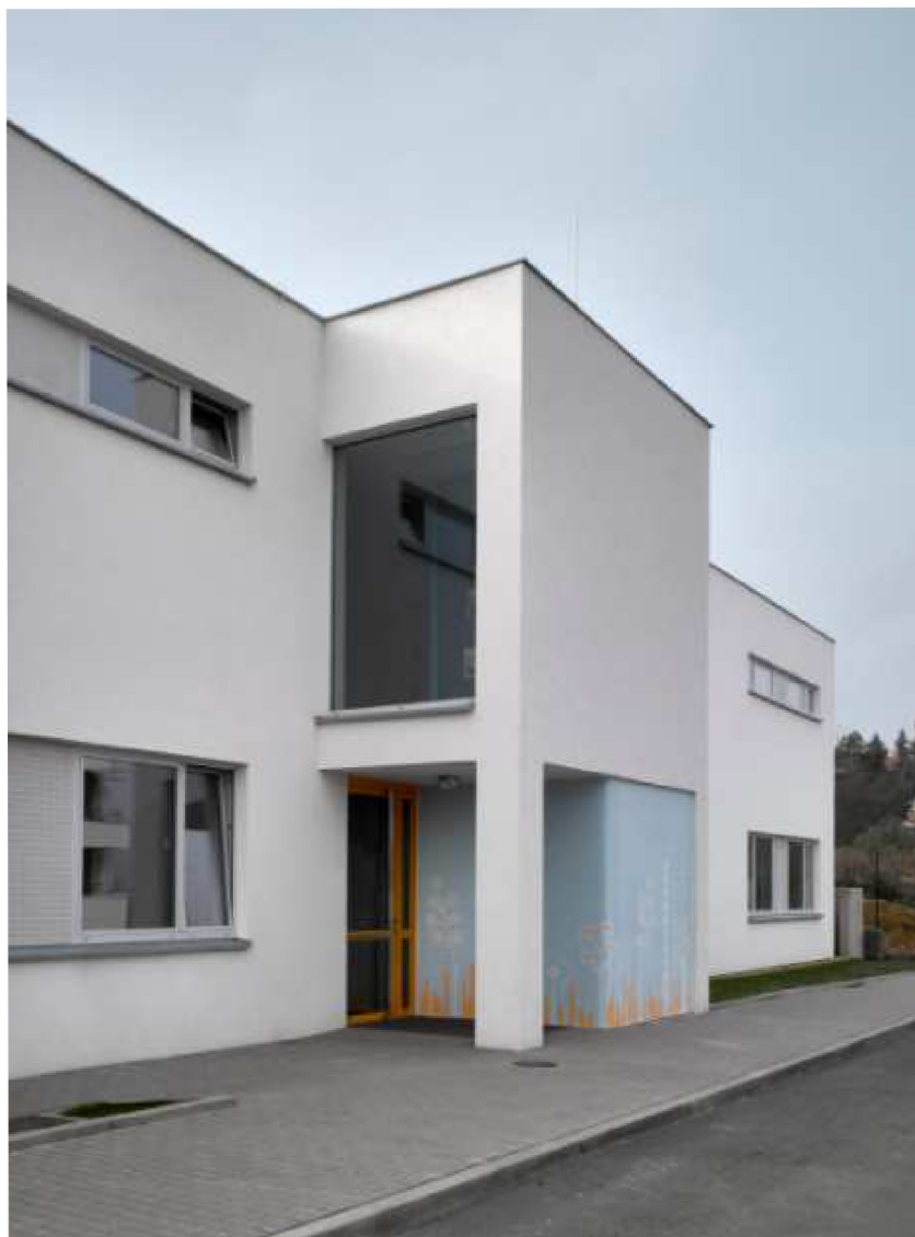
Obr. č. 29 Hlavní vstup do budovy školky
