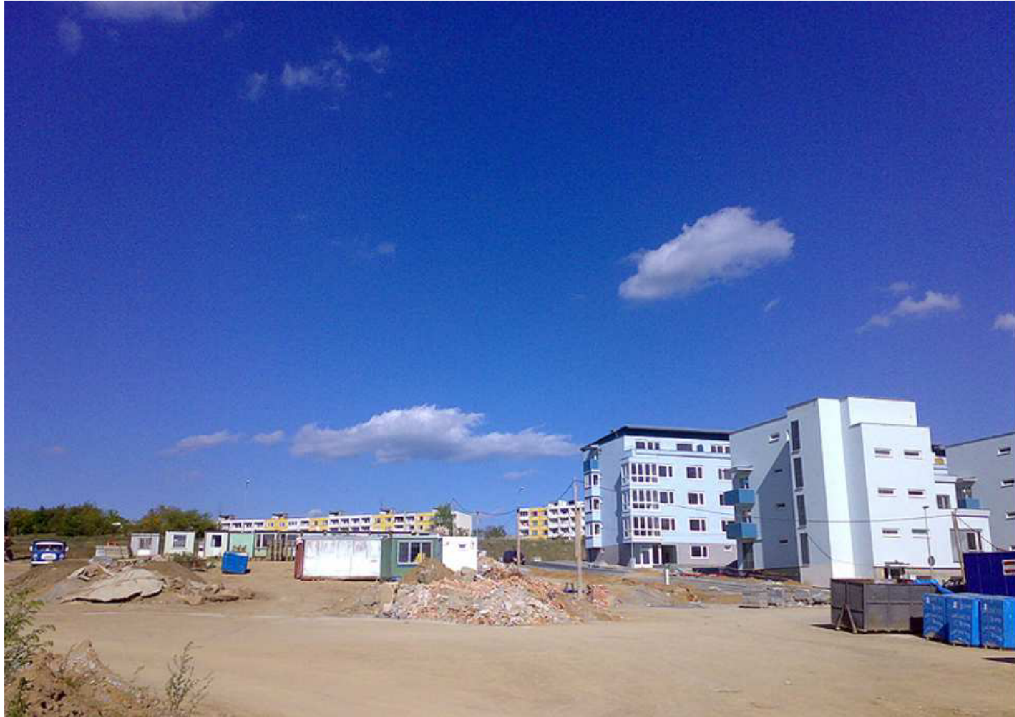
Obr. č. 20 Pohled na staveniště z etapy Kamechy I. [21]
