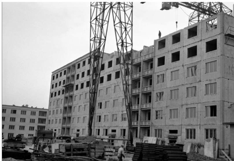
Obr. č. 17 Archivní fotografie výstavby panelových sídlišť proudovou metodou
