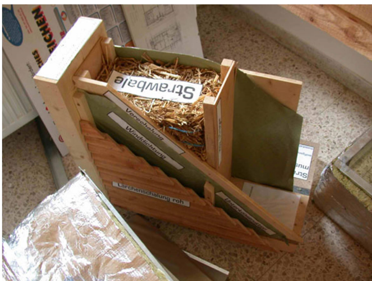
Obrázek č. 5 Vyobrazení skladby obvodového pláště s využitím slámy [15]
