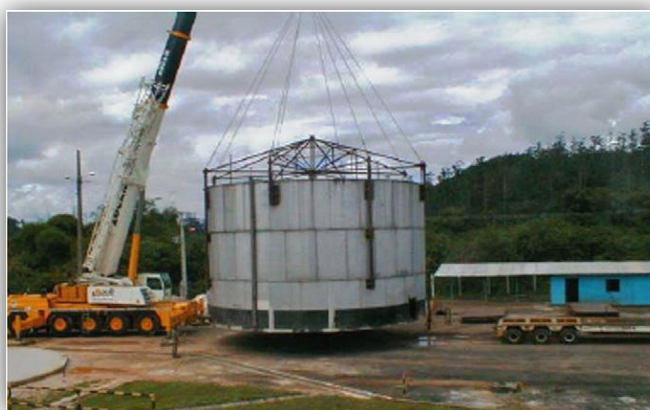
Obr. 3 Zvedání a transport skladovací nádrže ethanolu s hmotností 26 000 kg za pomoci lepených spojů
