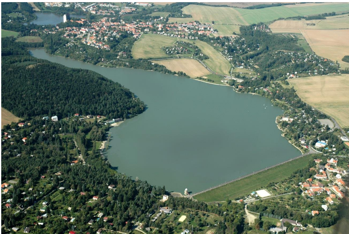
Fotodokumentace č. 3 – Letecký pohled na vodní nádrž Plumlov a její okolí vč. nad ní posazeného Podhradského rybníka v roce 2008 (Zdroj: Povodí Moravy, s. p.)
