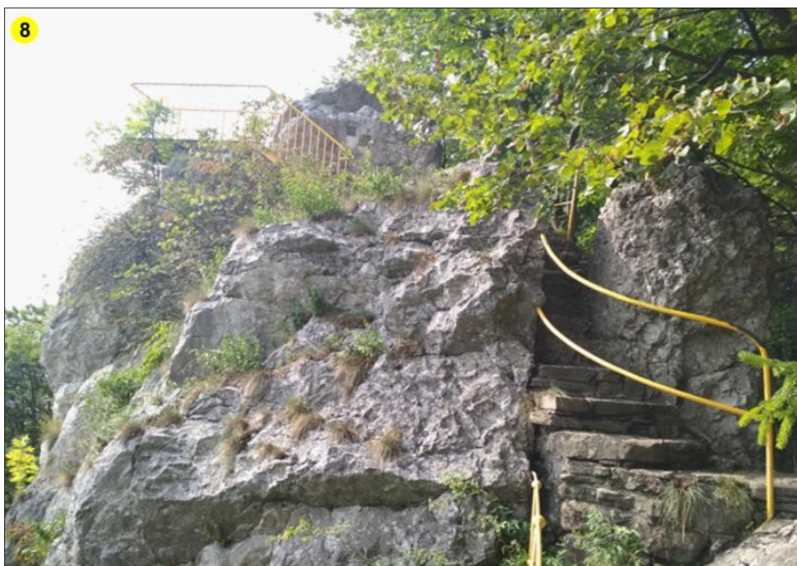
Obr. 18: Raškova skála s ocelovou lávkou, foto: autor
