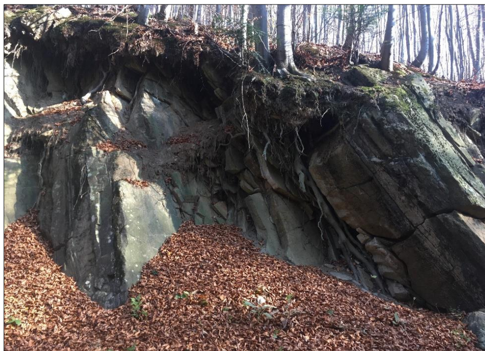
Obr. 6: Výchoz bašských vrstev slezské jednotky v masívu Červeného kamene, foto: autor
