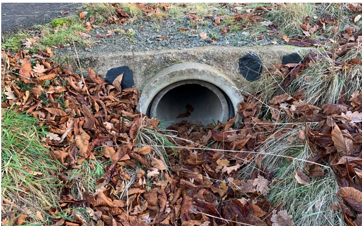
Obr. 103: Propustek s minimálním čelem
