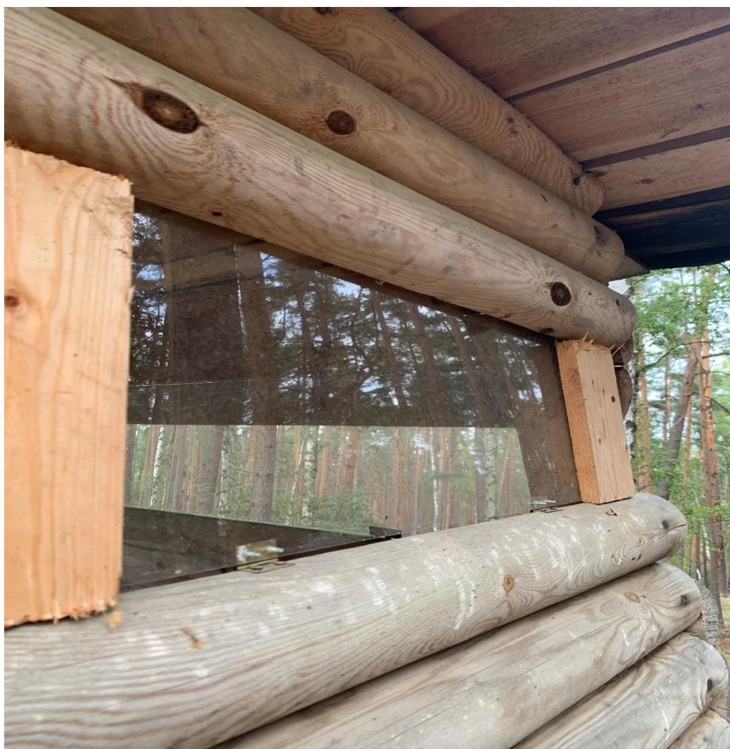
Obr. 32: Střilna krytá plexisklem
