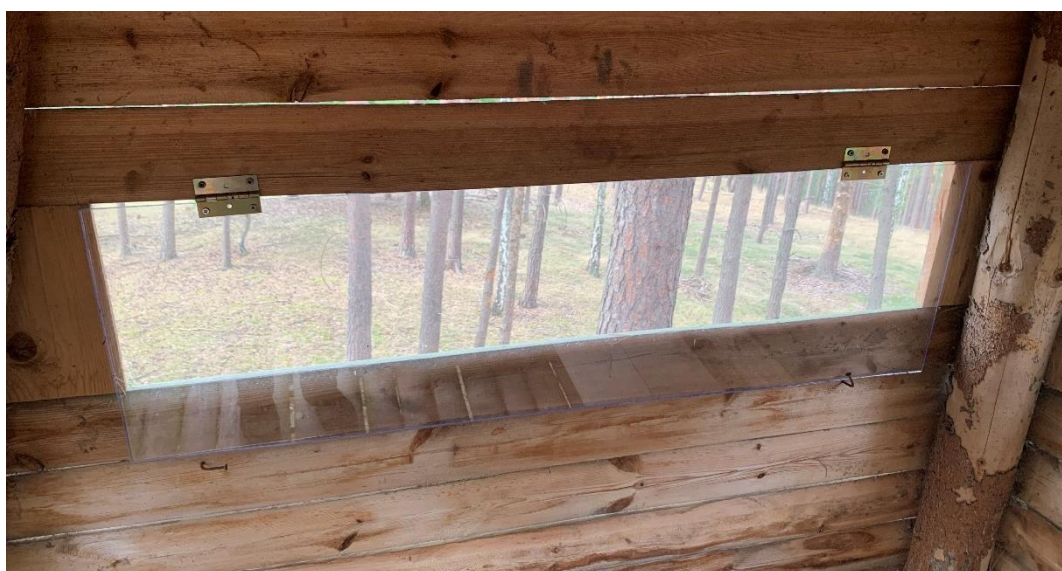
Obr. 33: Střilna krytá plexisklem
