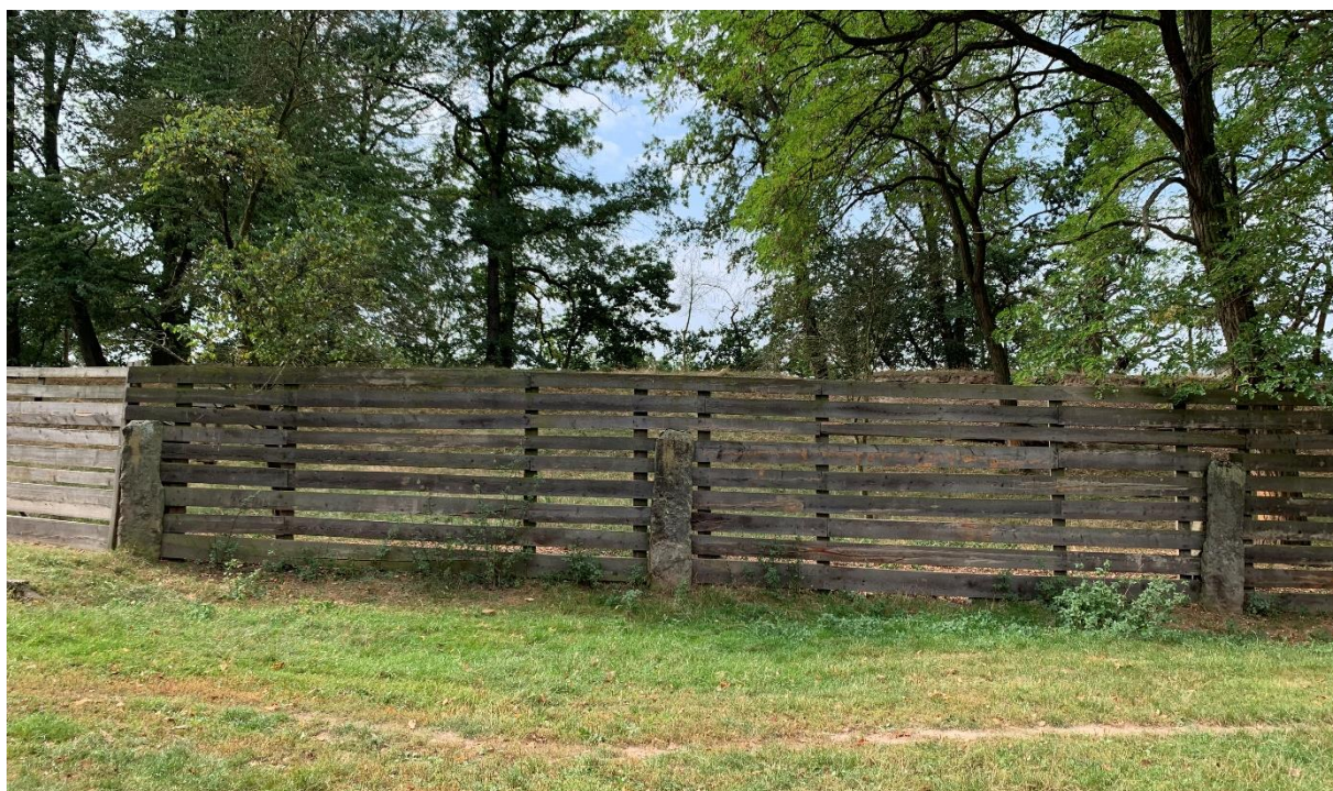
Obr. 112: Plot z modřínových fošen s pískovcovými sloupky
