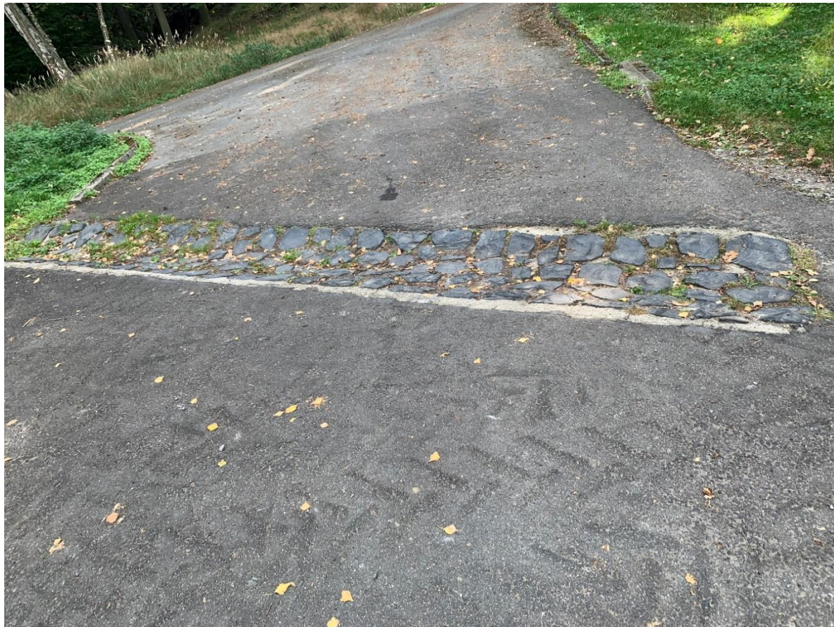
Obr. 23: Zemní průleh z kamenné dlažby na lesní cestě „Na Vřísek“
