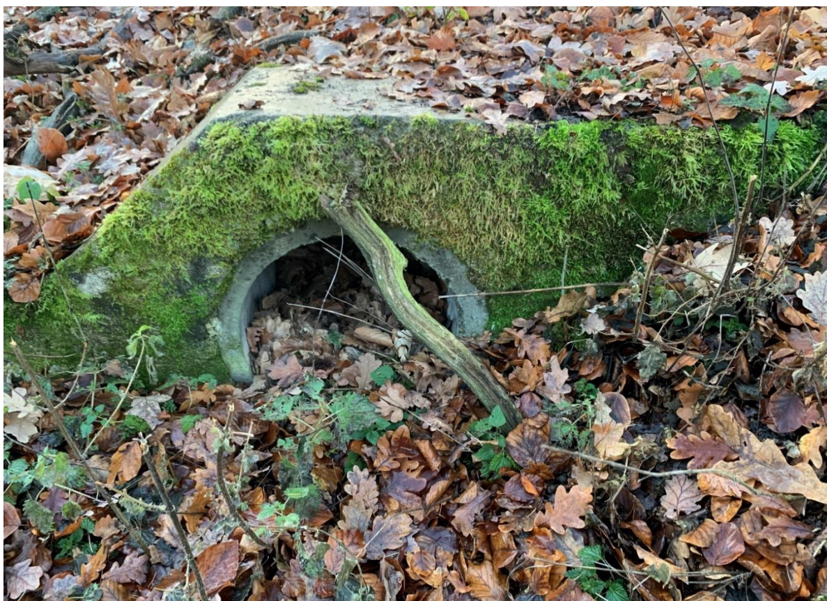
Obr. 102: Propustek s minimálním čelem
