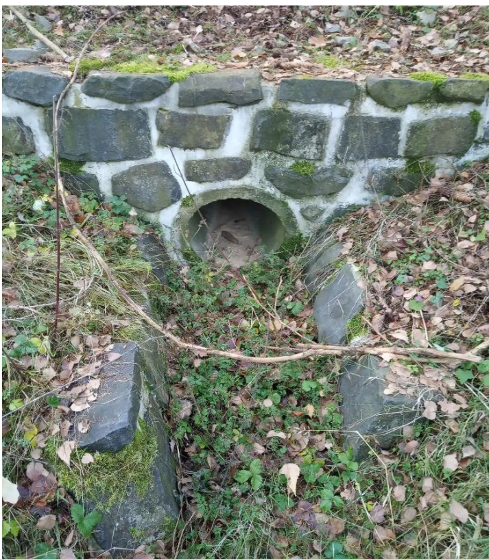
Obr. 101: Propustek s čelem z čediče
