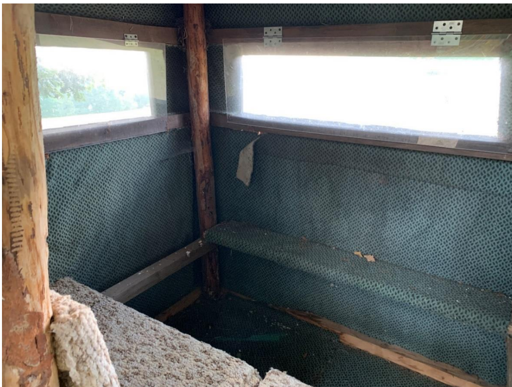
Obr. 44: Vnitřek kazatelny se zateplením z koberce
