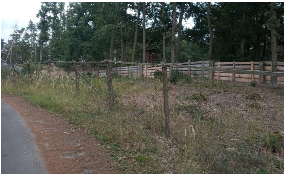
Obr. 113: Plot z lesnické pletiva se smrkovými sloupy – oplocenka
