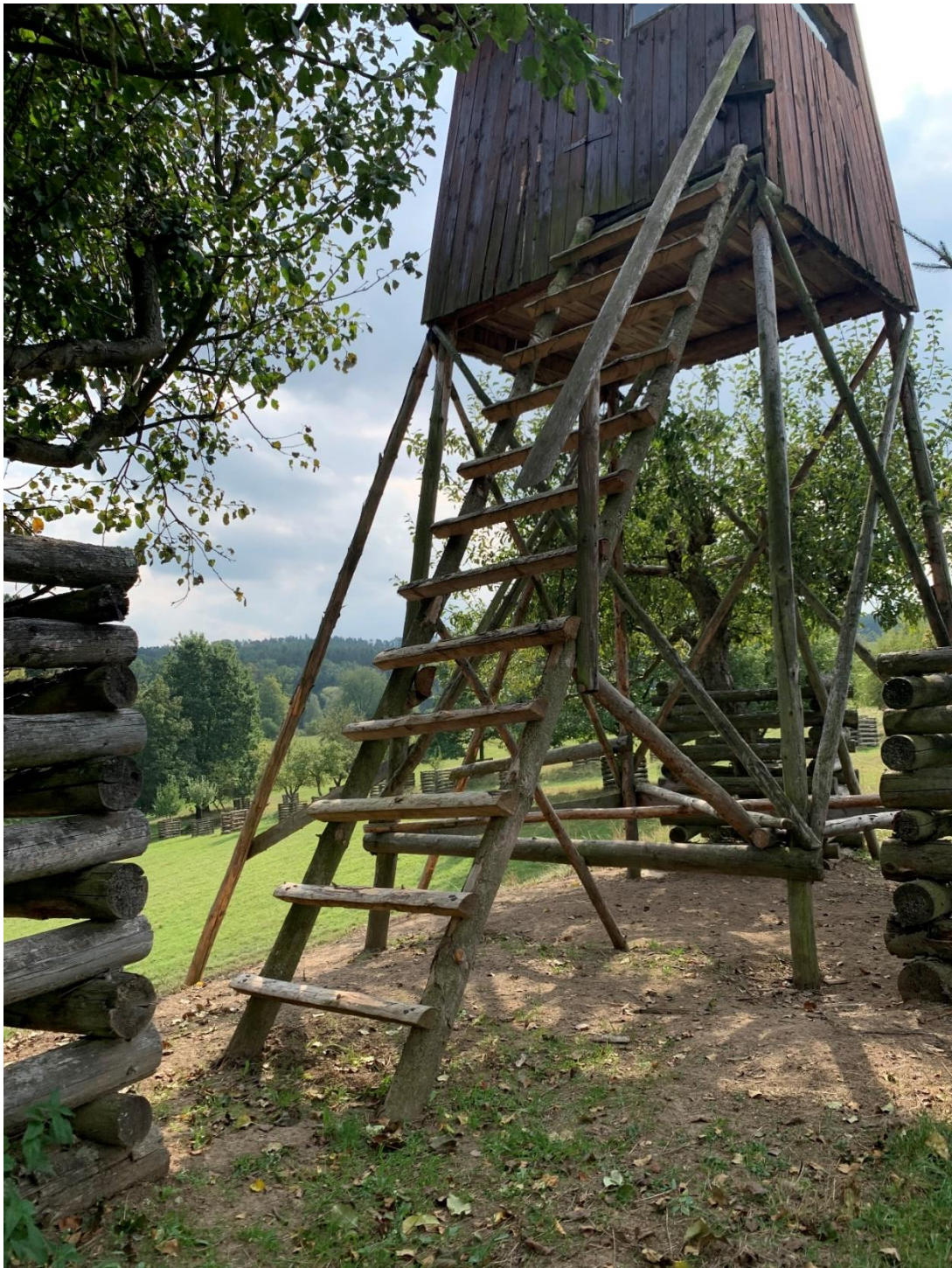
Obr. 48: Žebřík se zábradlím
