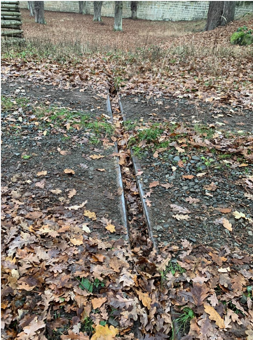
Obr. 22: Svodnice vody na lesní cestě „V aleji“
