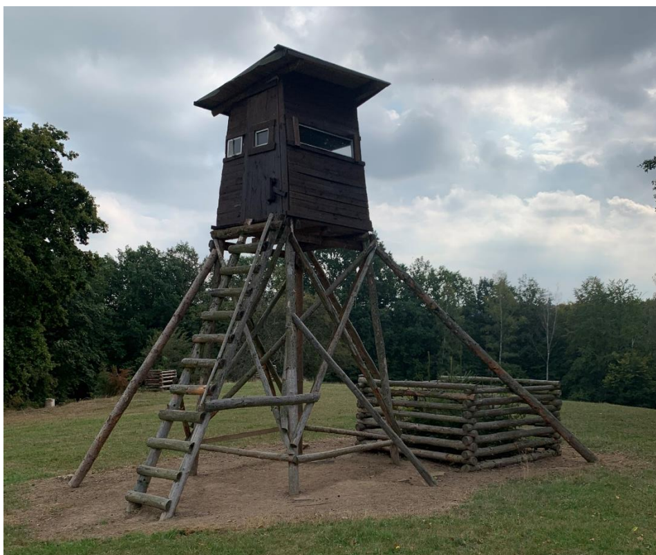
Obr. 49: Kazatelna s pultovou střechou
