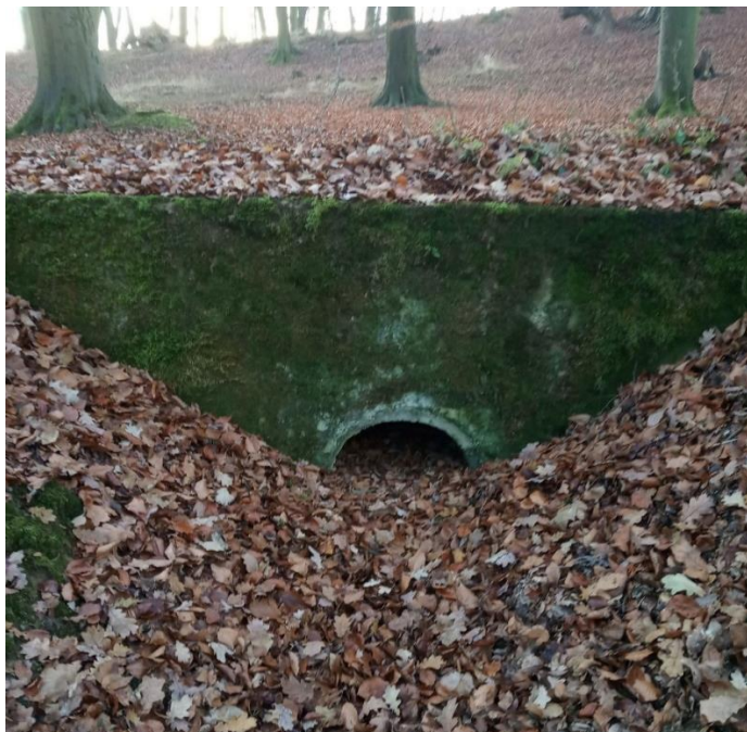
Obr. 20: Betonové čelo propustku
