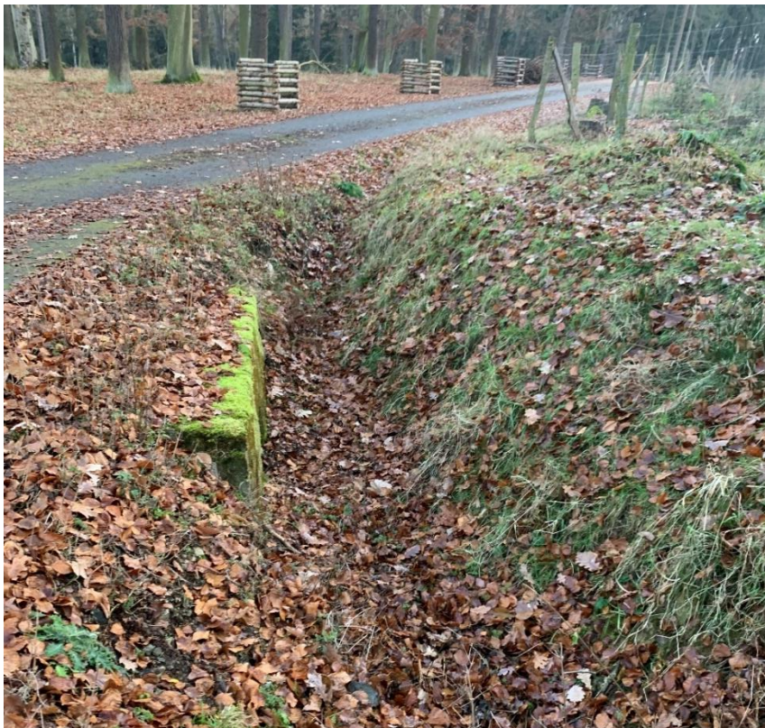
Obr. 100: Propustek s betonovým čelem
