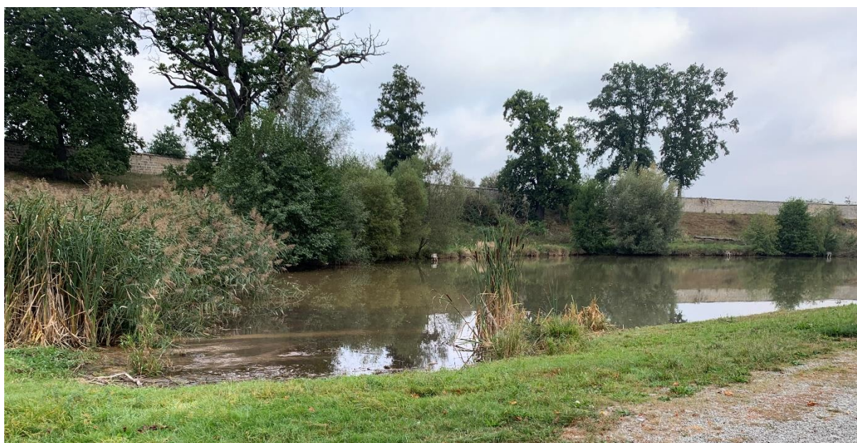
Obr. 128: Vodní nádrž, pohled na západní část
