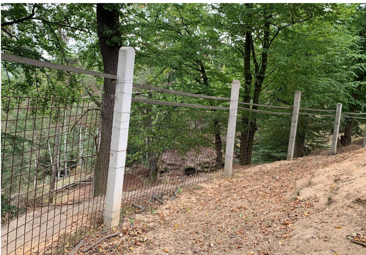
Obr. 108: Plot z kari sítě s železobetonovými sloupy
