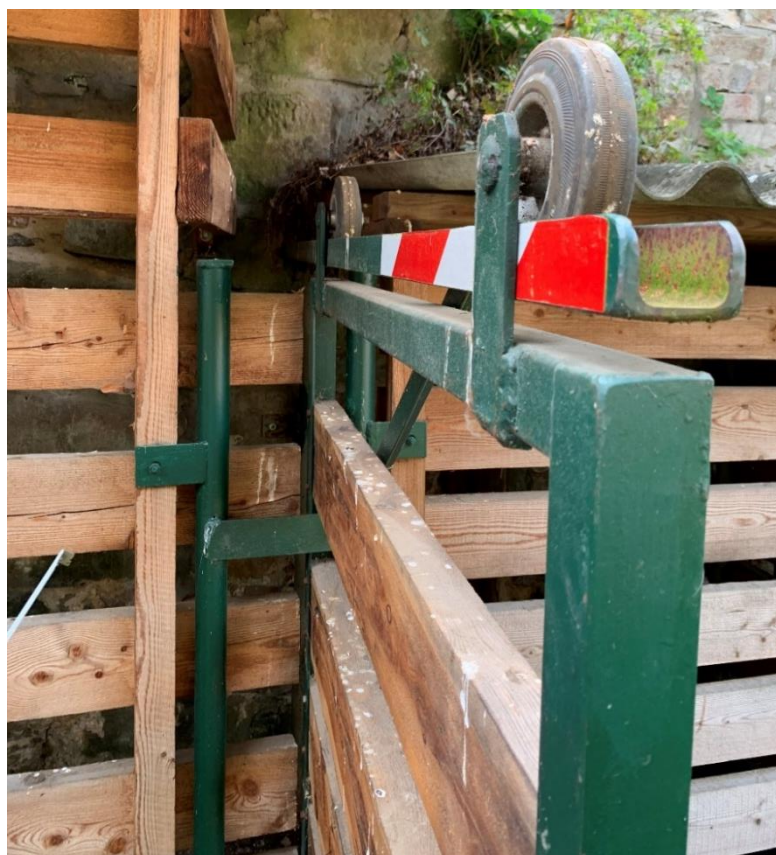
Obr. 74: Kolejnice pro vysunutí přepážek jednotlivých kójí u odchyťového zařízení
