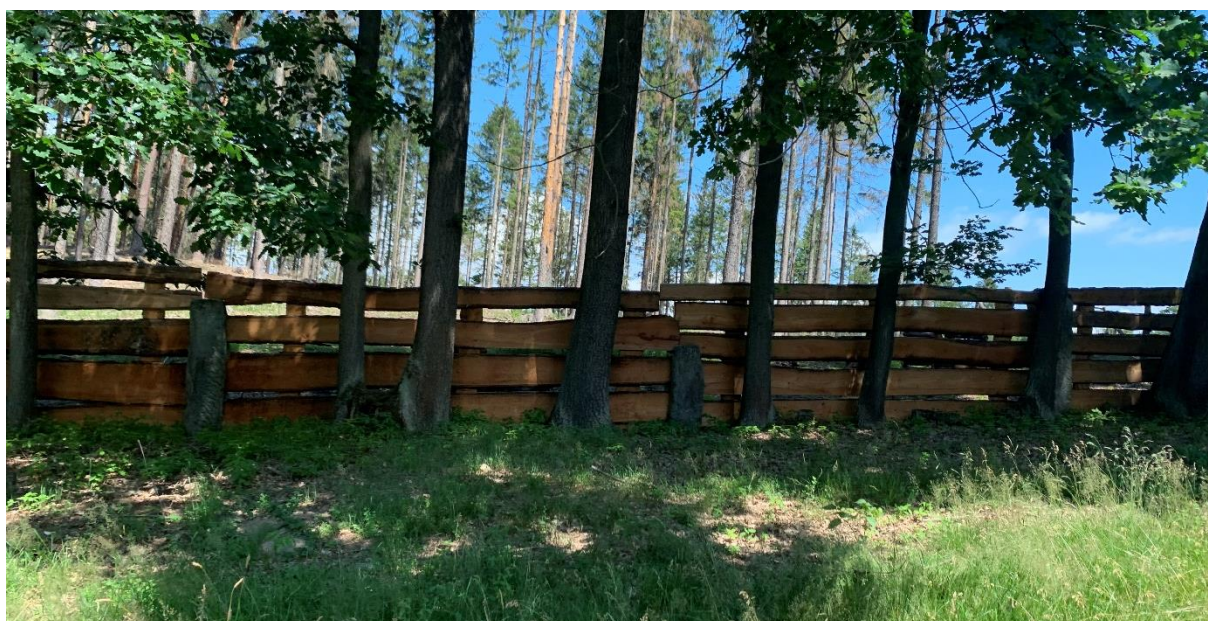
Obr. 110: Rekonstruovaný plot z modřínových fošen s pískovcovými sloupky
