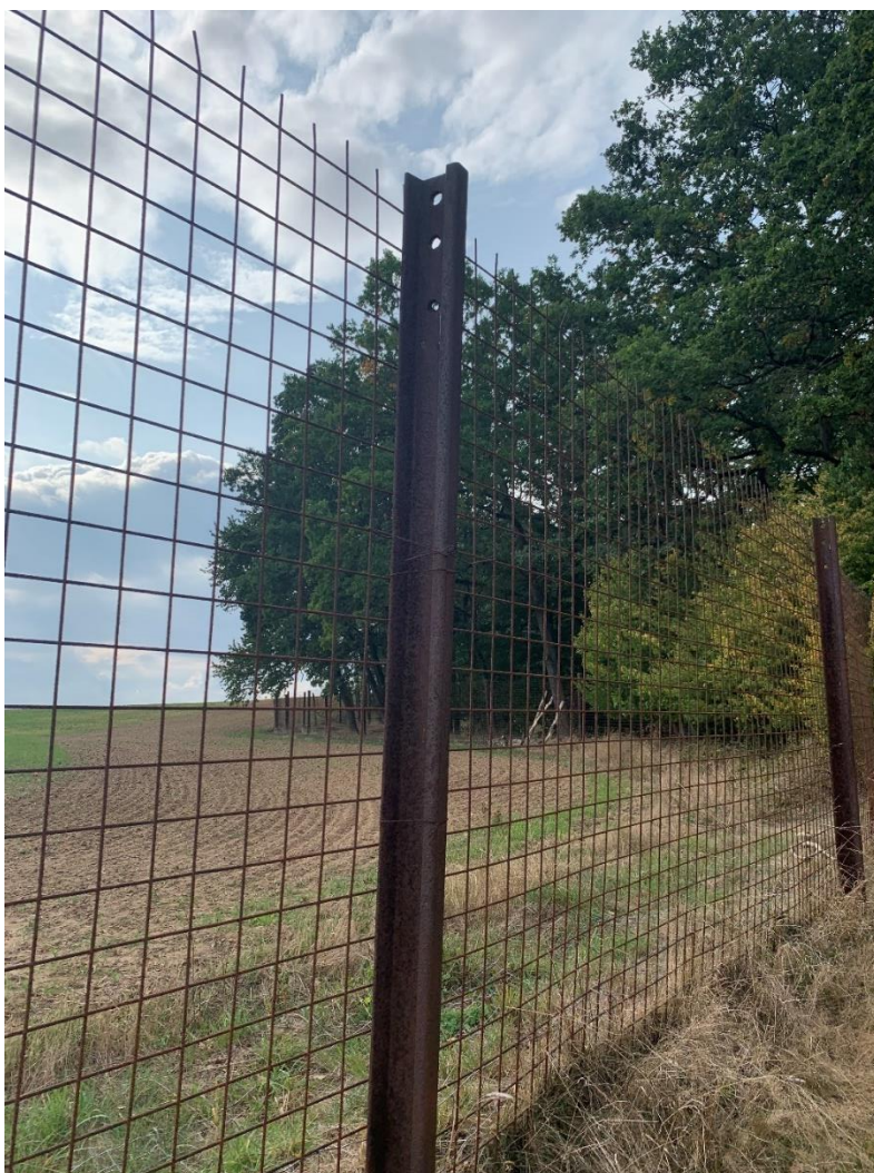
Obr. 109: Plot z kari sítě se sloupky z rozřezaných kolejnic
