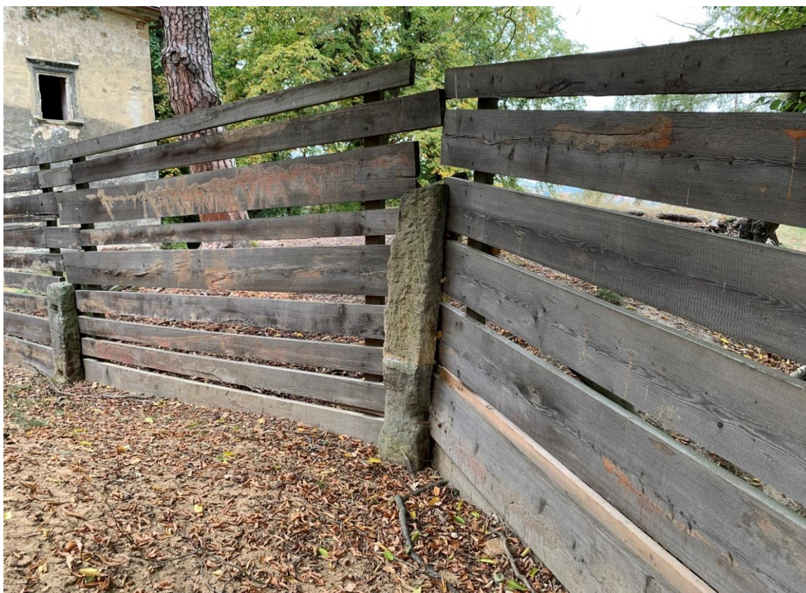
Obr. 111: Plot z modřínových fošen s pískovcovými sloupky
