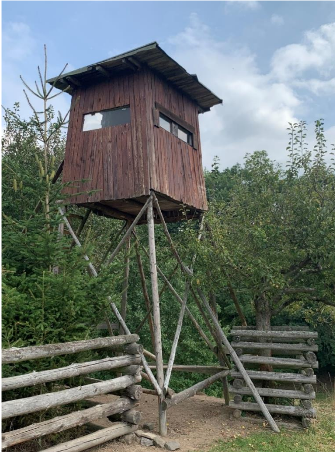
Obr. 1: Kazatelna s pultovou střechou
