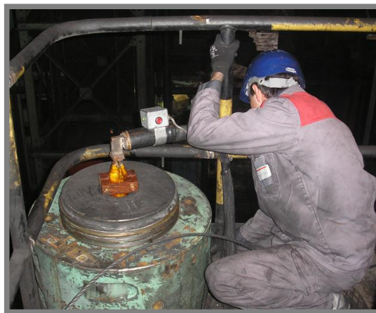
Obr. 20 Vyvození předpětí elektrickým indukčním zahřátím šroubu [41]
