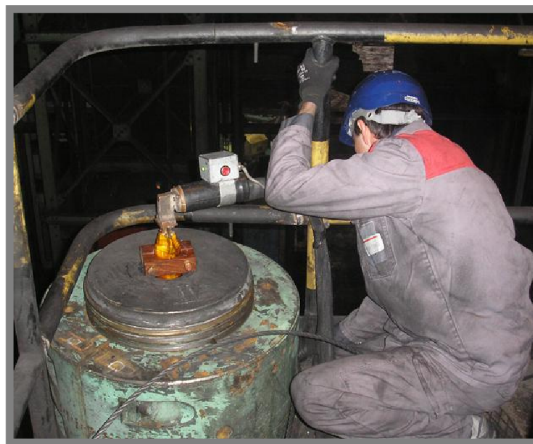
Obr. 20 Vyvození předpětí elektrickým indukčním zahřátím šroubu [41]
