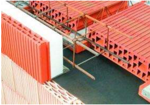
Obrázek 31 - Příprava pozedního věnce před zmonolitněním betonem [11]
