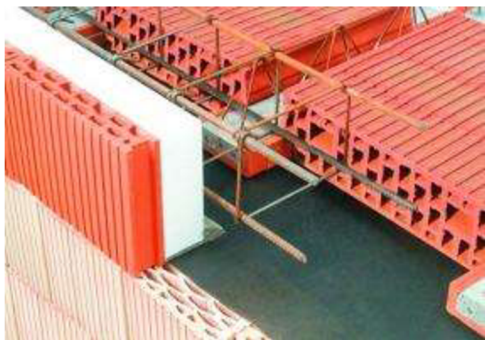
Obrázek 31 - Příprava pozedního věnce před zmonolitněním betonem [11]
