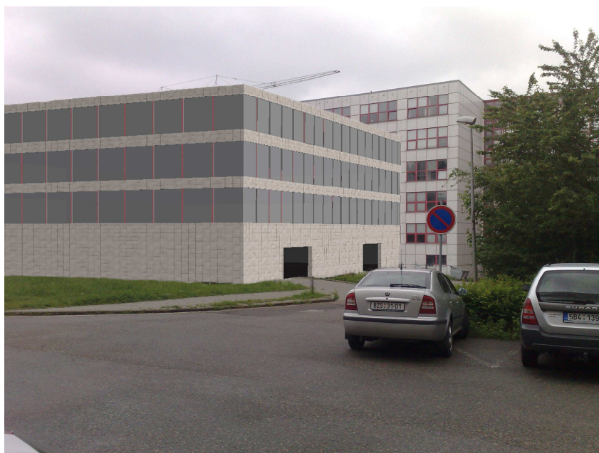
Obr. 40: Parkovací dům za budovou VUT FEKT
