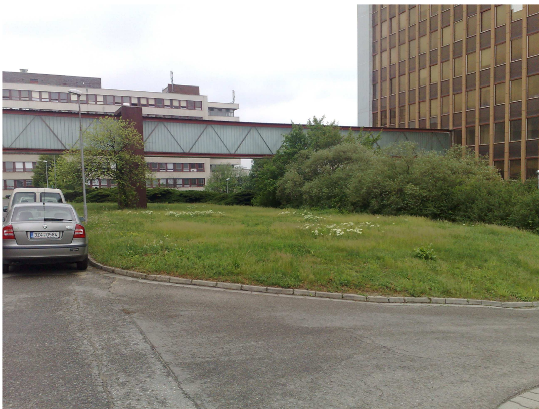
Obr. 36: Travnatá plocha za budovou A1 (pohled od vjezdu do areálu)
