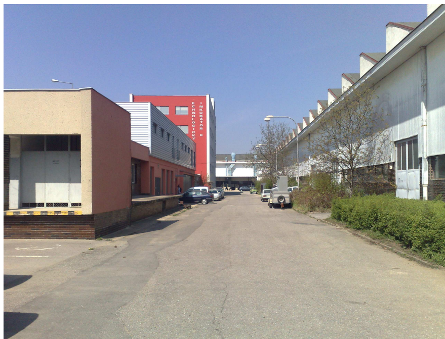
Obr. 24: Parkování mezi budovami C1, C2 a D2, D3
