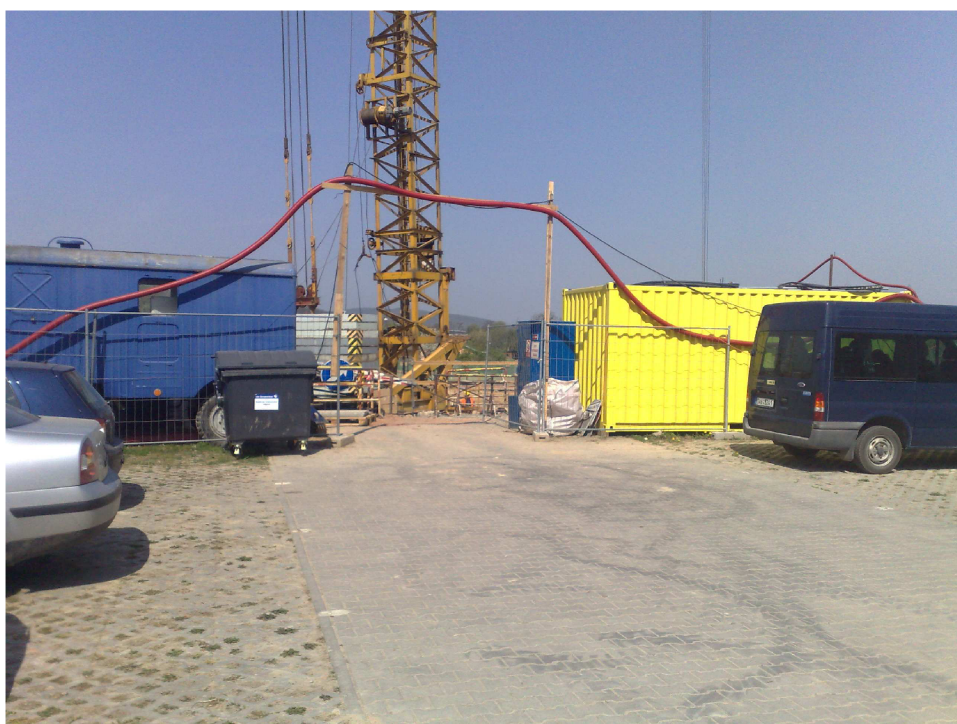
Obr. 33: Stavební práce na parkovací ploše za budovou VUT FEKT
