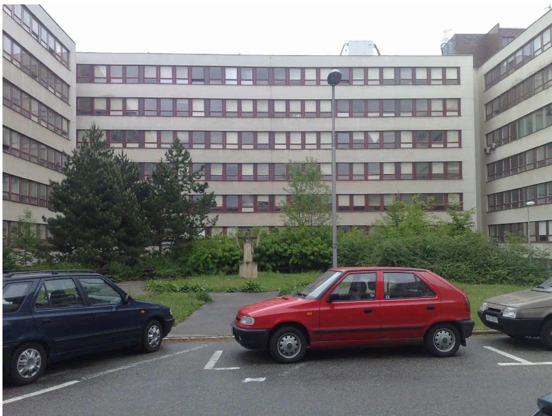
Obr. 38: Travnatá plocha mezi budovami A2, A3 a A4 (pohled na budovu A4)
