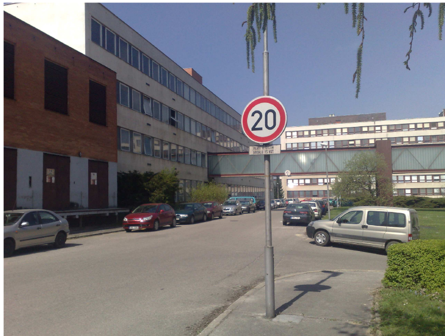
Obr. 20: Parkování před budovou B1
