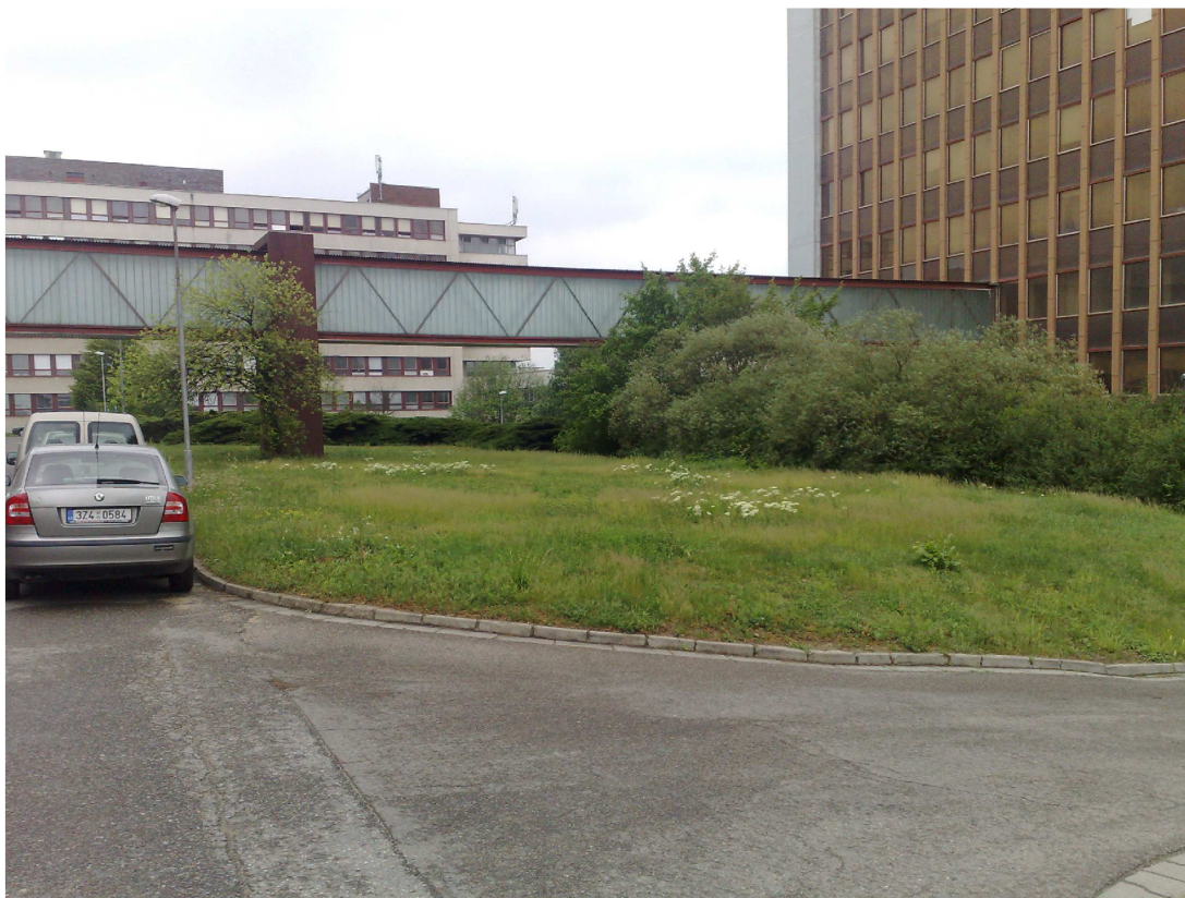
Obr. 36: Travnatá plocha za budovou A1 (pohled od vjezdu do areálu)
