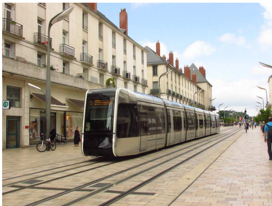
Obrázek 10 - Příklad úseku se spodním přívodem napájení (Tours, Francie) [47]
