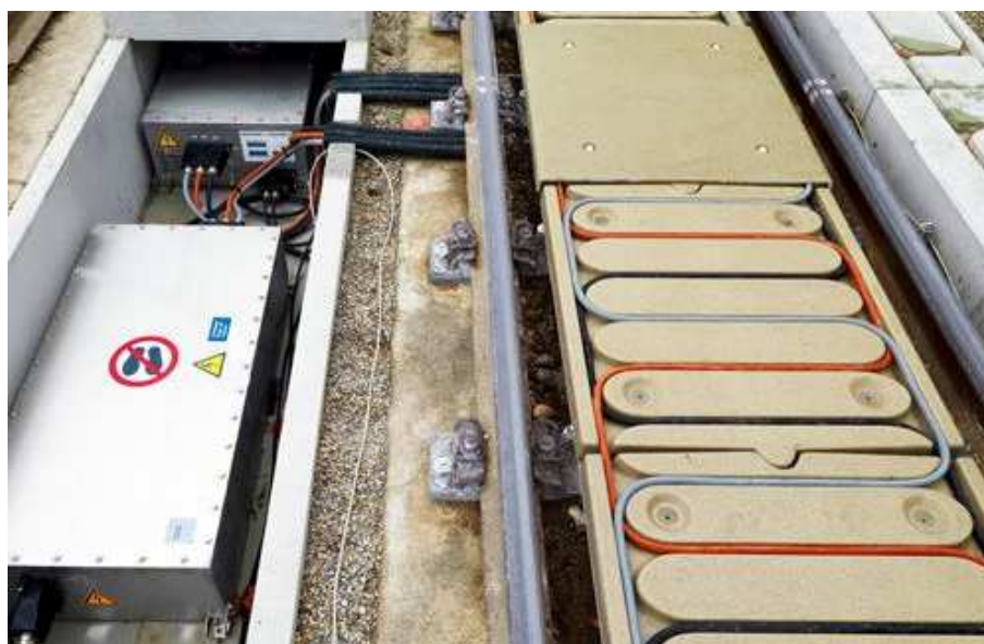
Obrázek 11 - Indukční segment zabudovaný v kolejišti [48]
