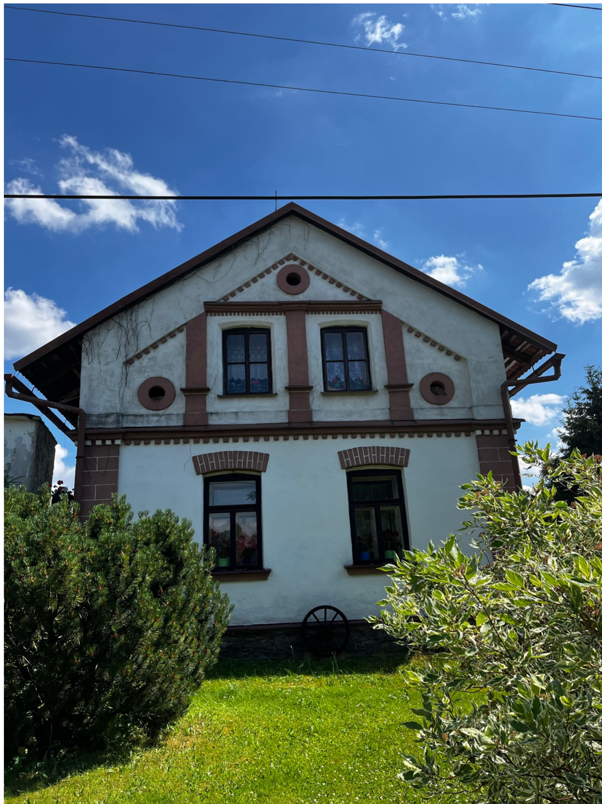
Bývalá kovárna v Bačetíně č. 31, byla postavena před rokem 1864, přesná datace chybí. Foto autora
