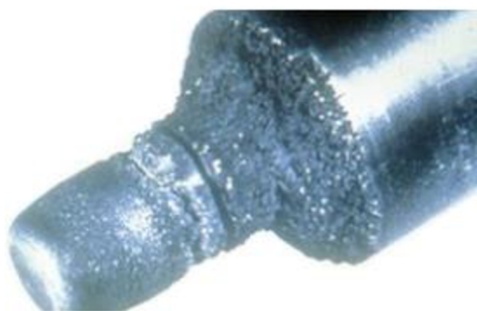
Obr. 11.1 Kavitační poškození vnitřní části ventilu [15]
