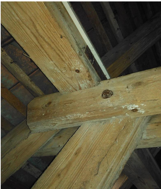
Obr. 25: Zapuštění vaznice do kleštiny
