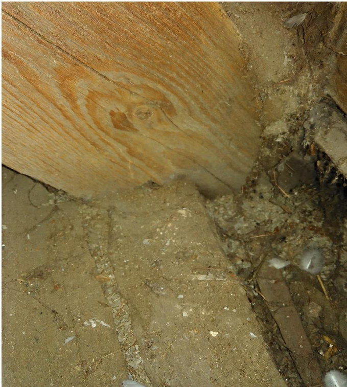
Obr. 24: Osedlání krokve na pozednici
