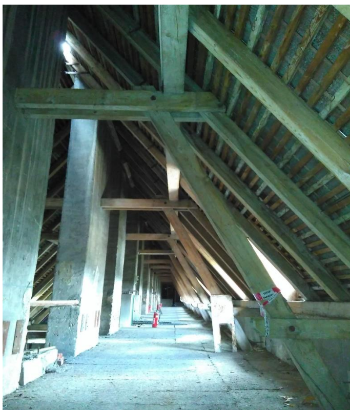
Obr. 22: Severní strana konstrukce
