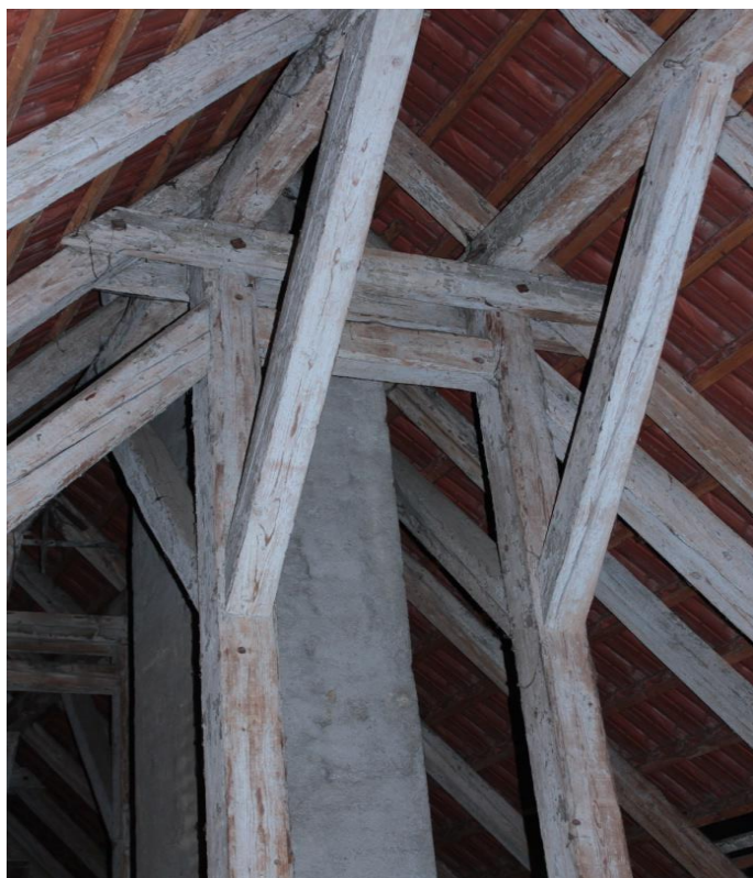
Obr. 18: Pohled na vaznice podepřené kleštinami a sloupky s pásy
