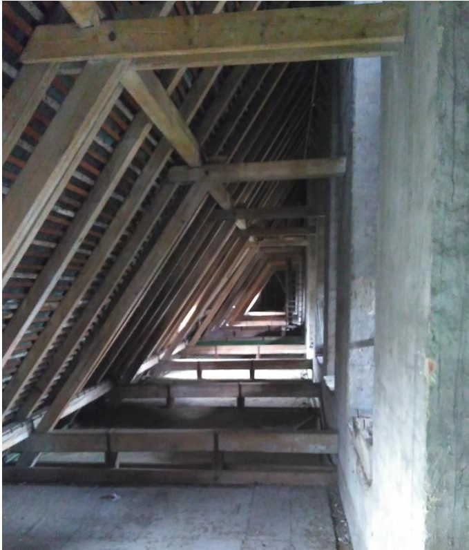
Obr. 23: Jižní strana konstrukce
