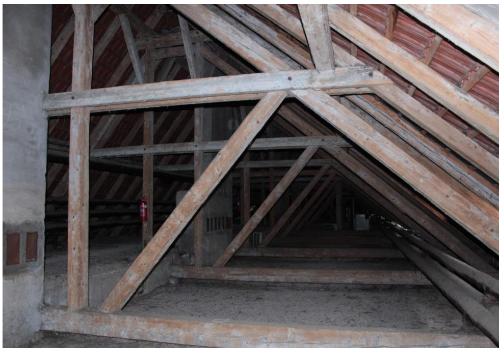
Obr. 19: Šikmá vzpěra plní funkci příčného zavětrování, spojuje vazný trám a vzpěru vaznice
