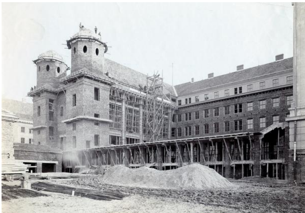
Obr. 8: Fotografie z alba dokumentující výstavbu budovy, které daroval univerzitnímu archivu v roce 2000 Dr. Ing. Leoš Hobst z Brna ( www.mendelu.cz )
