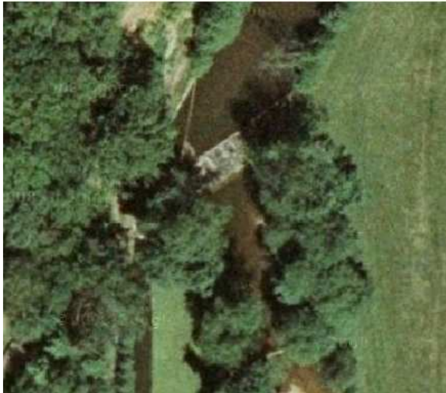
Obr. 6.3.1-1 Letecký snímek jezu v Sobkovicích [5]
