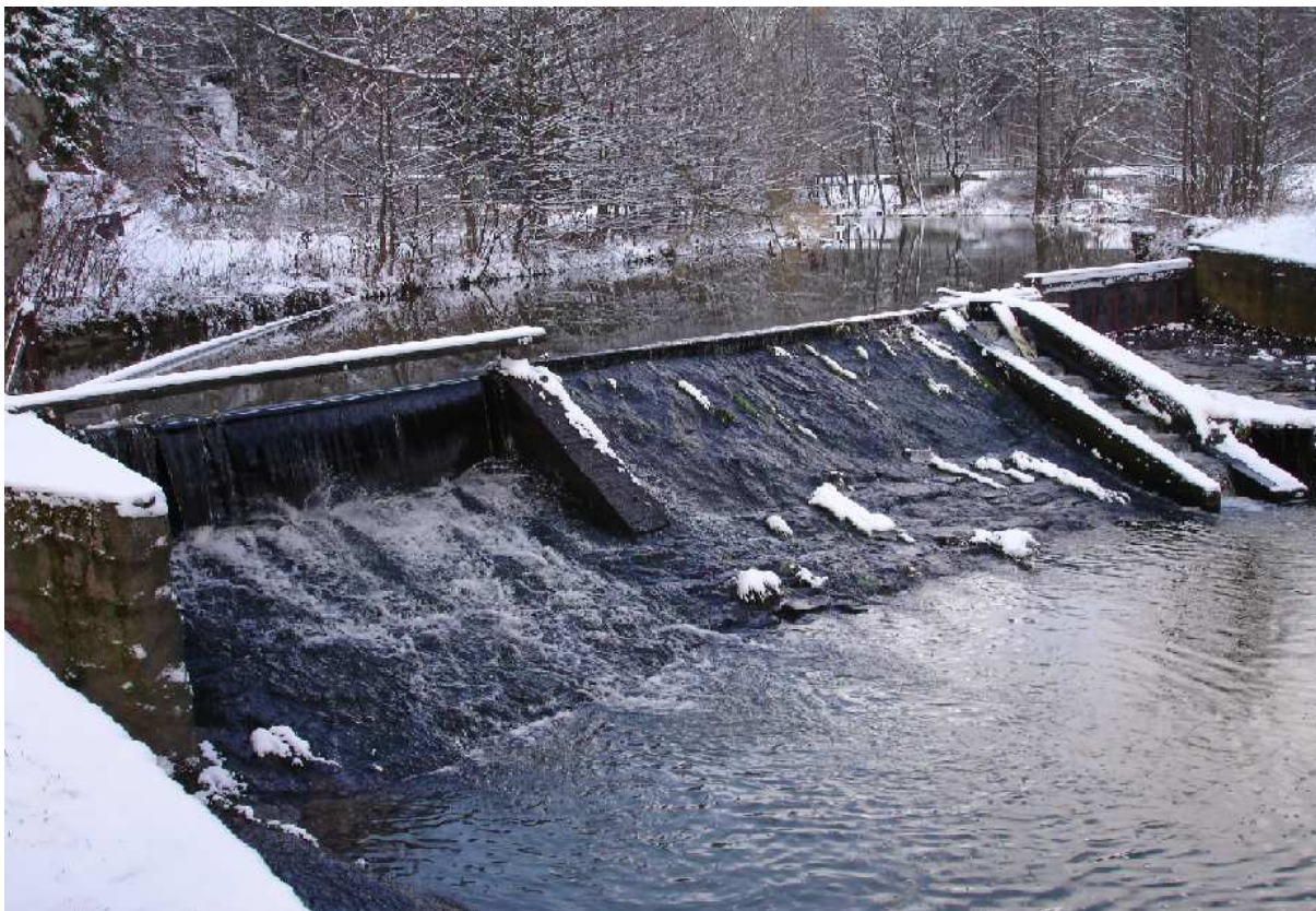
Obr. 6.3.1-2 Fotografie jezu v Sobkovicích
