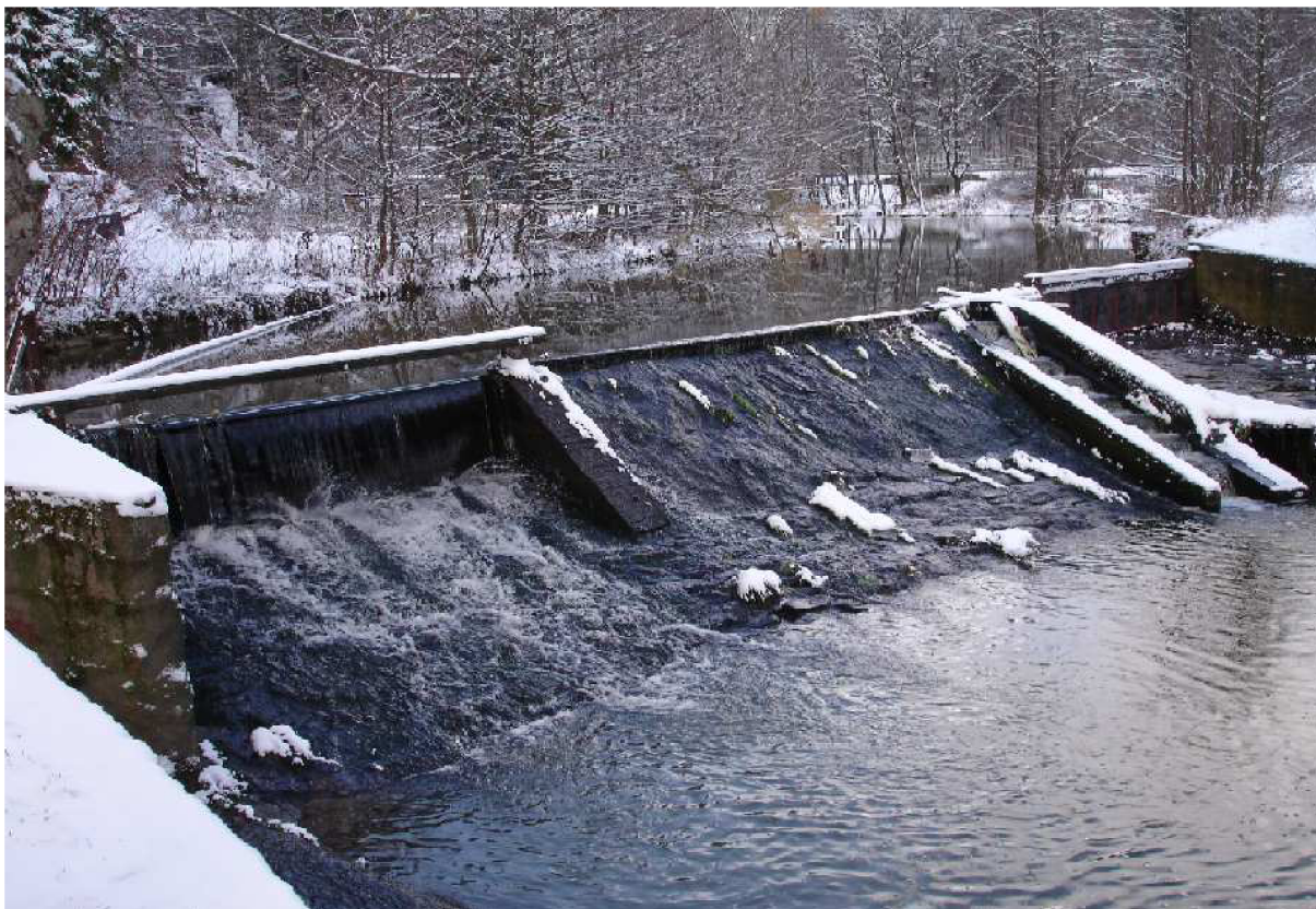
Obr. 6.3.1-2 Fotografie jezu v Sobkovicích
