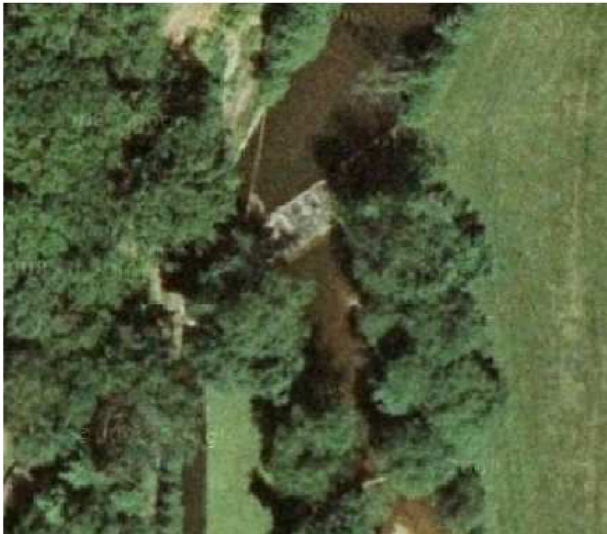
Obr. 6.3.1-1 Letecký snímek jezu v Sobkovicích [5]
