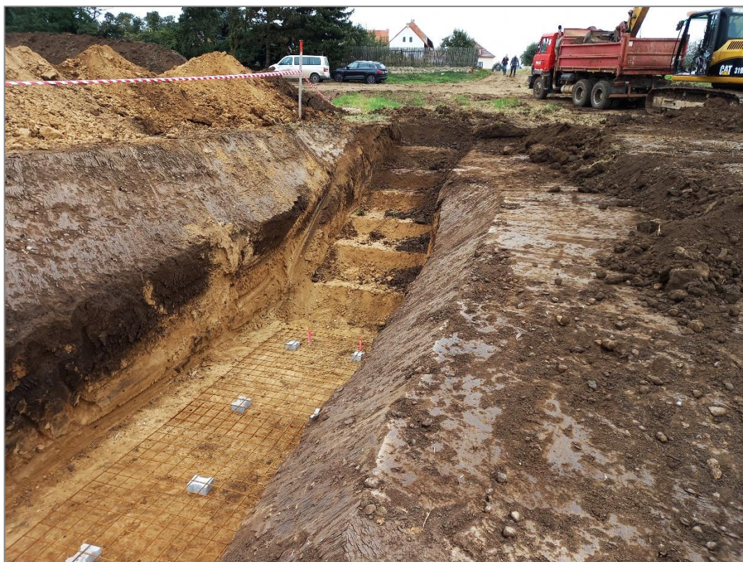
Obrázek 34 Dokumentace z výkopových prací stavby poldru v k.ú. Ctiněves Zdroj: vlastní fotodokumentace
