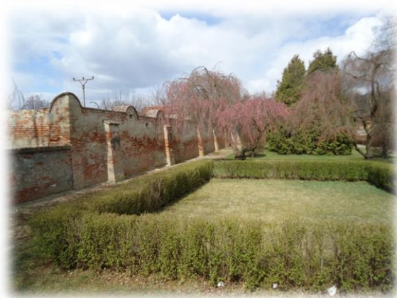
Obrázek 51: Pohled na obvodovou zeď (Foto: Puchoňová, 2012)
