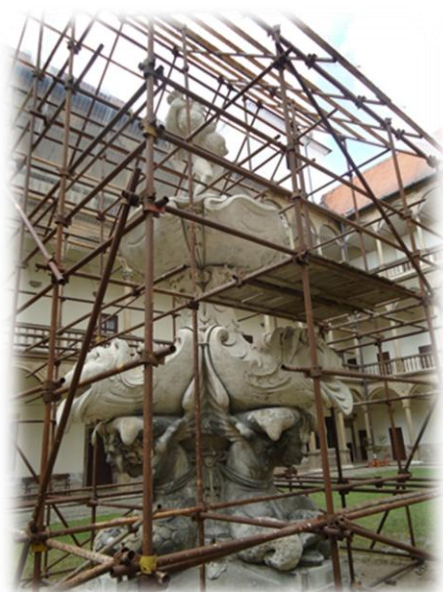
Obrázek 39: Kašna v nádvoří, probíhající rekonstrukce (Foto: Puchoňová,2012)
