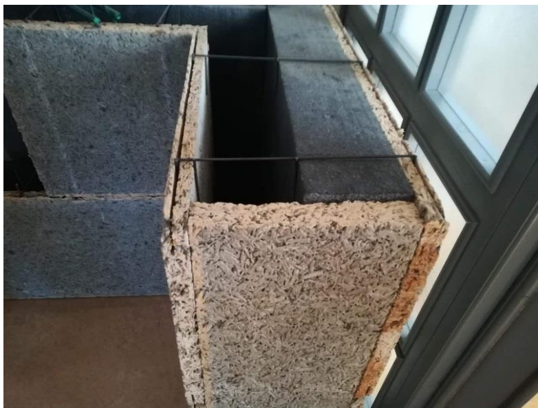
Obr. 20 Štěpkocementové desky Izolox (autor)
