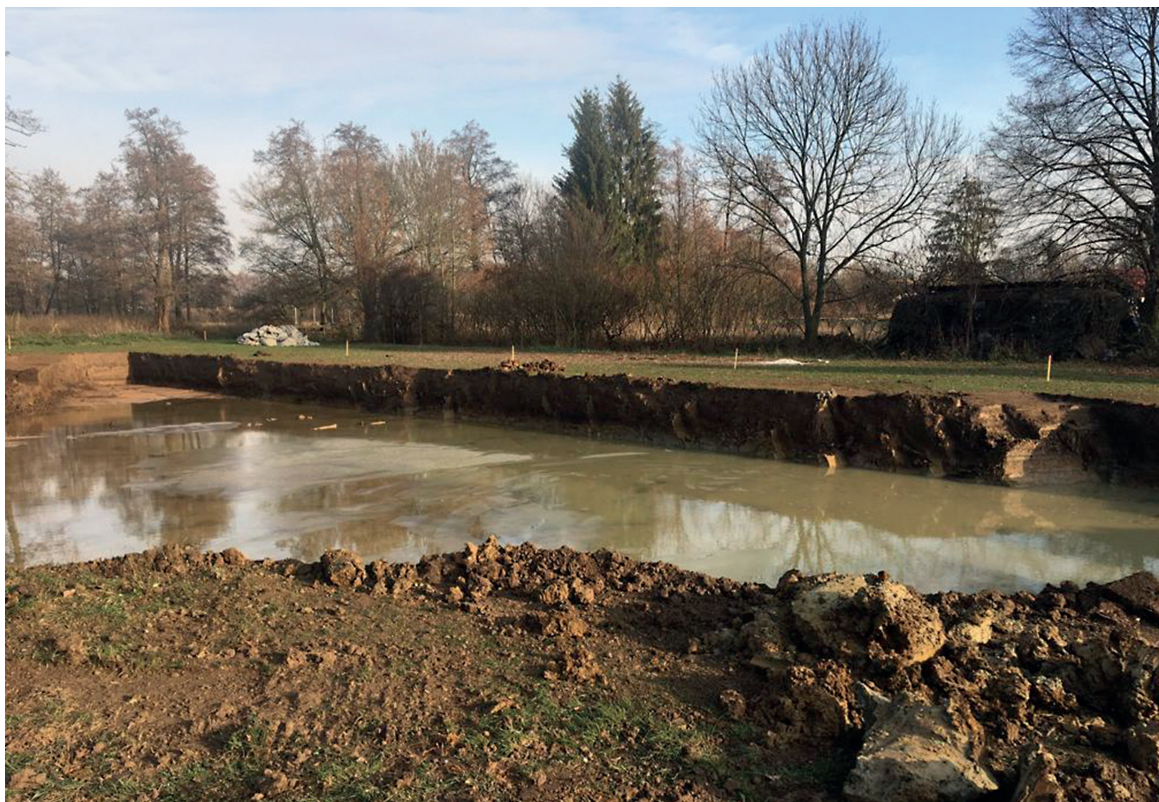
Obrázek 9: Budování mokřadní plochy (Pavel Koller 2018)
