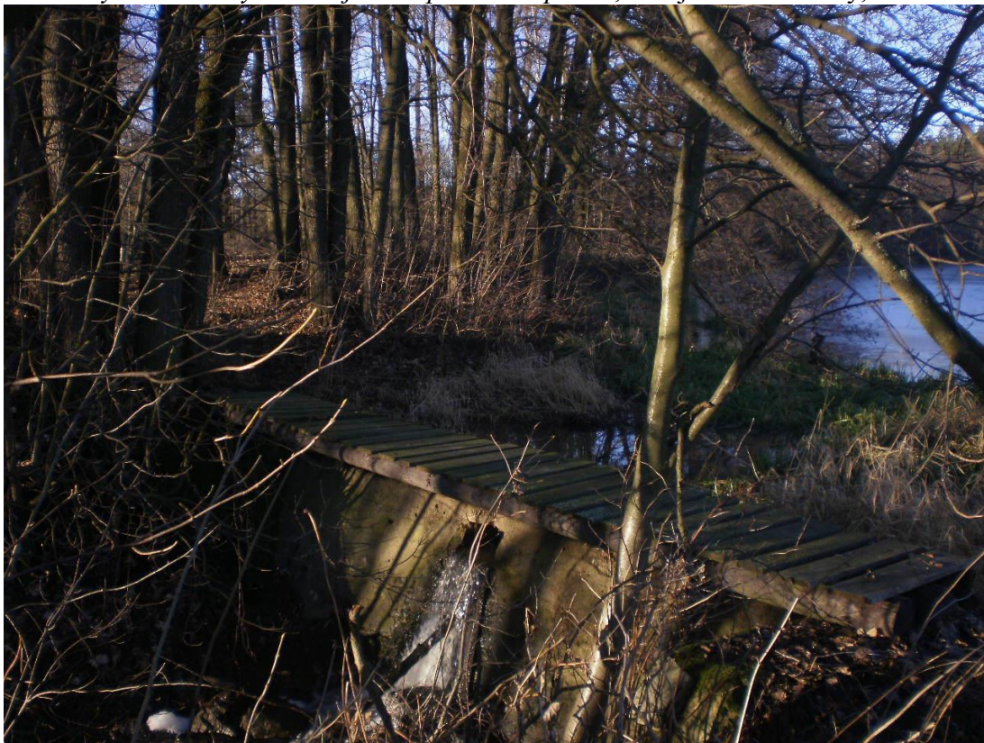
Obr.6: Rybník Panský – stávající bezpečnostní přeliv , zdroj: foto Poslušný, 2014
