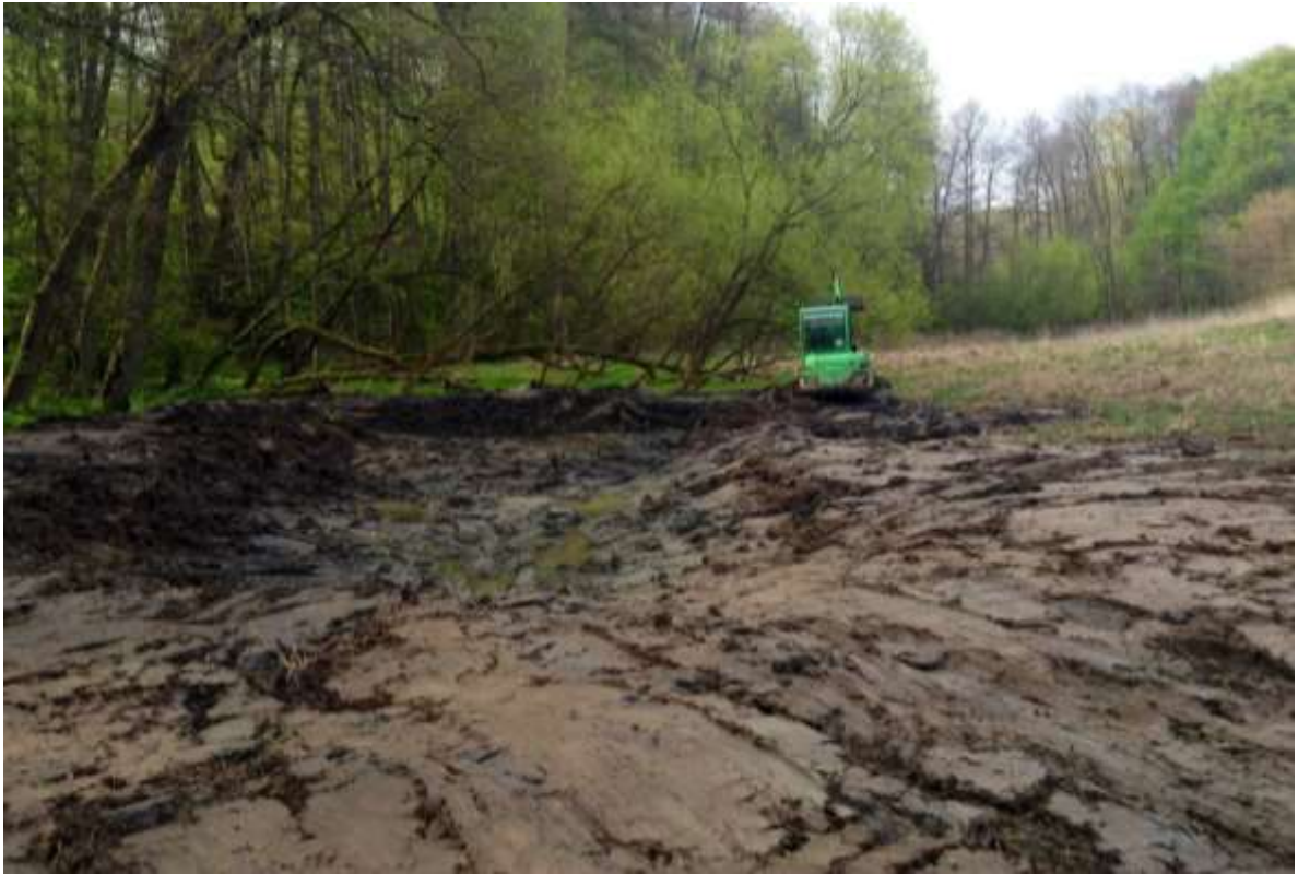
OBRÁZEK 208 TERÉNNÍ ÚPRAVY. (FOTO JAN AMBRŮZ, 2014)
