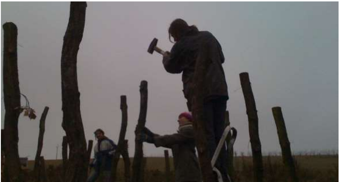
OBRÁZEK 155 BUDOVÁNÍ ZÁKLADŮ PAVUČINY - 19. (FOTO JAN AMBRŮZ, 2011)
