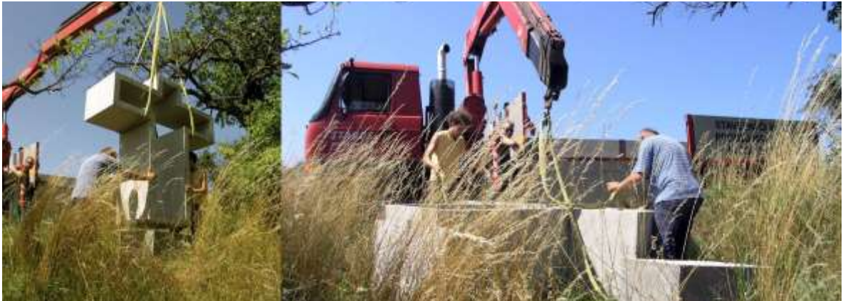
OBRÁZEK 96 INSTALACE KŘÍŽOVÉ CESTY PODÉL ÚVOZU ( FOTO PAVLA KAČÍRKOVÁ, 2008)
