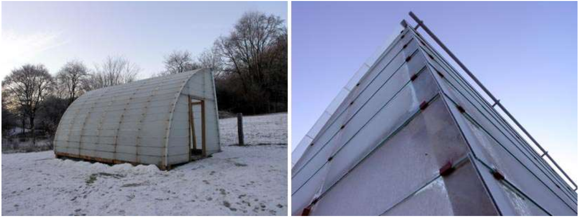
OBRÁZEK 85 SKLENÍK. CELEK A DETAIL UCHYCENÍ SKEL NA DŘEVĚNOU KONSTRUKCI. (FOTO JAN AMBRŮZ, 2007)
