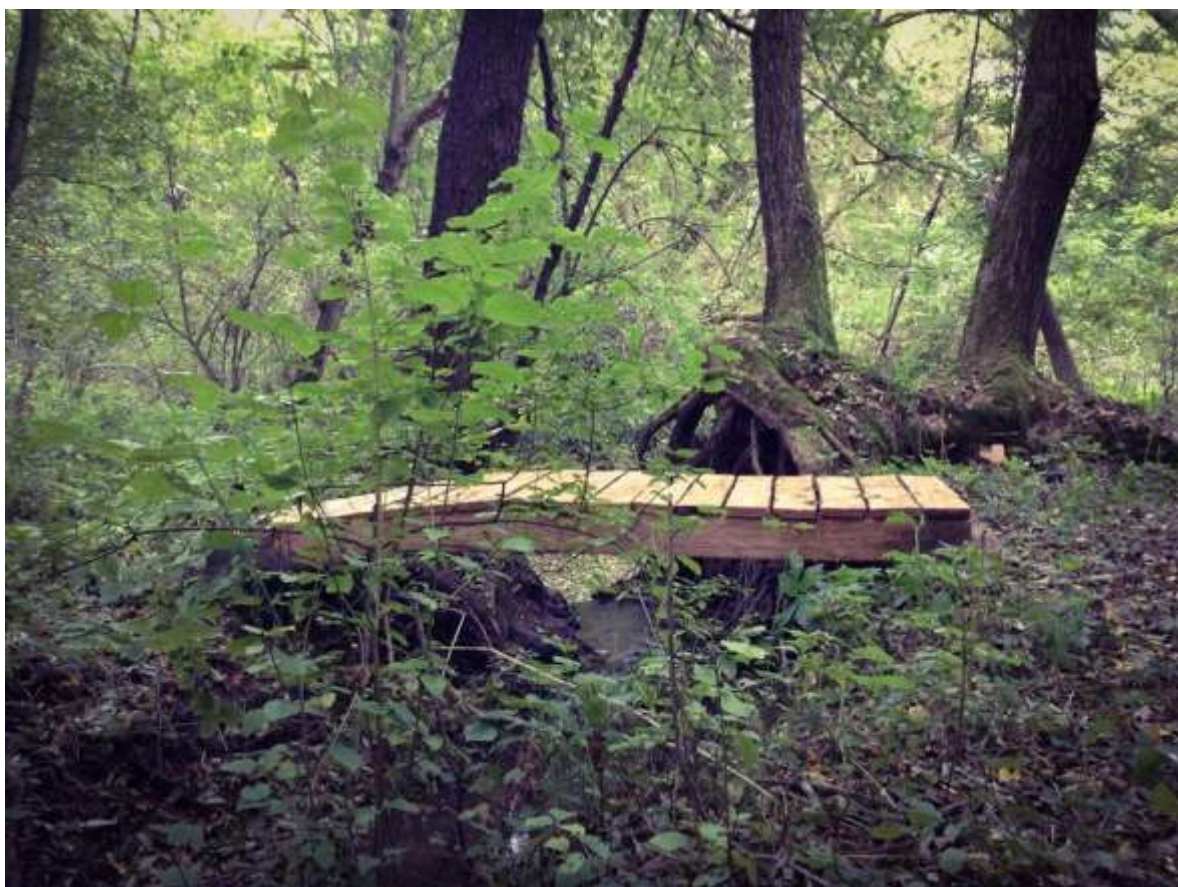
OBRAZEK 28 LÁVKA PŘES POTOK U CESTY NA LHOTU, JAN AMBRŮZ 2013. (FOTO JAN AMBRŮZ, 2013)
