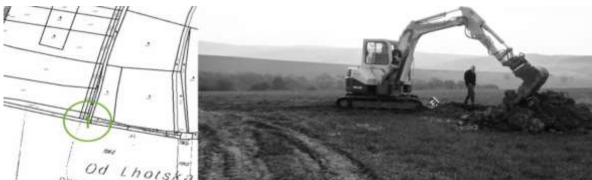
OBRÁZEK 111 VÝKOPOVÉ PRÁCE ZÁKLADŮ. (FOTO PAVLA KAČÍRKOVÁ)
