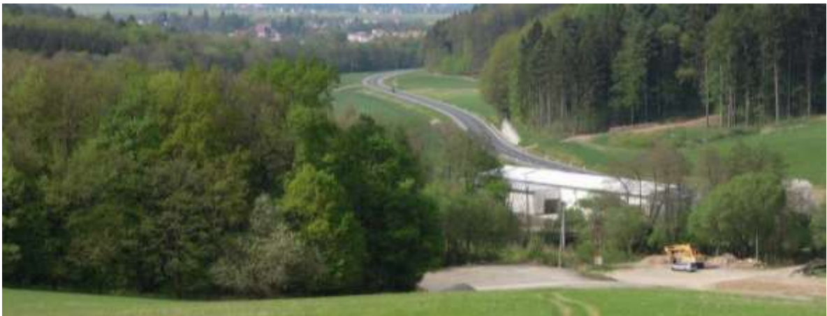
OBRAZEK 9 DOKONČENÁ PŘELOŽKA SILNICE, KOLEM NÍŽ PROBÍHAL ARCHEOLOGICKÝ VÝZKUM. ZE SNÍMKU JE PATRNÉ, JAK NEŠETRNĚ A NELOGICKY VEDE STŘEDEM POLE NOVÁ SILNICE. DŘÍVĚ SILNICE LOGICKY LEMOVALA HORNÍ OKRAJ LESA. (FOTO JAN AMBRŮZ, 2012)
