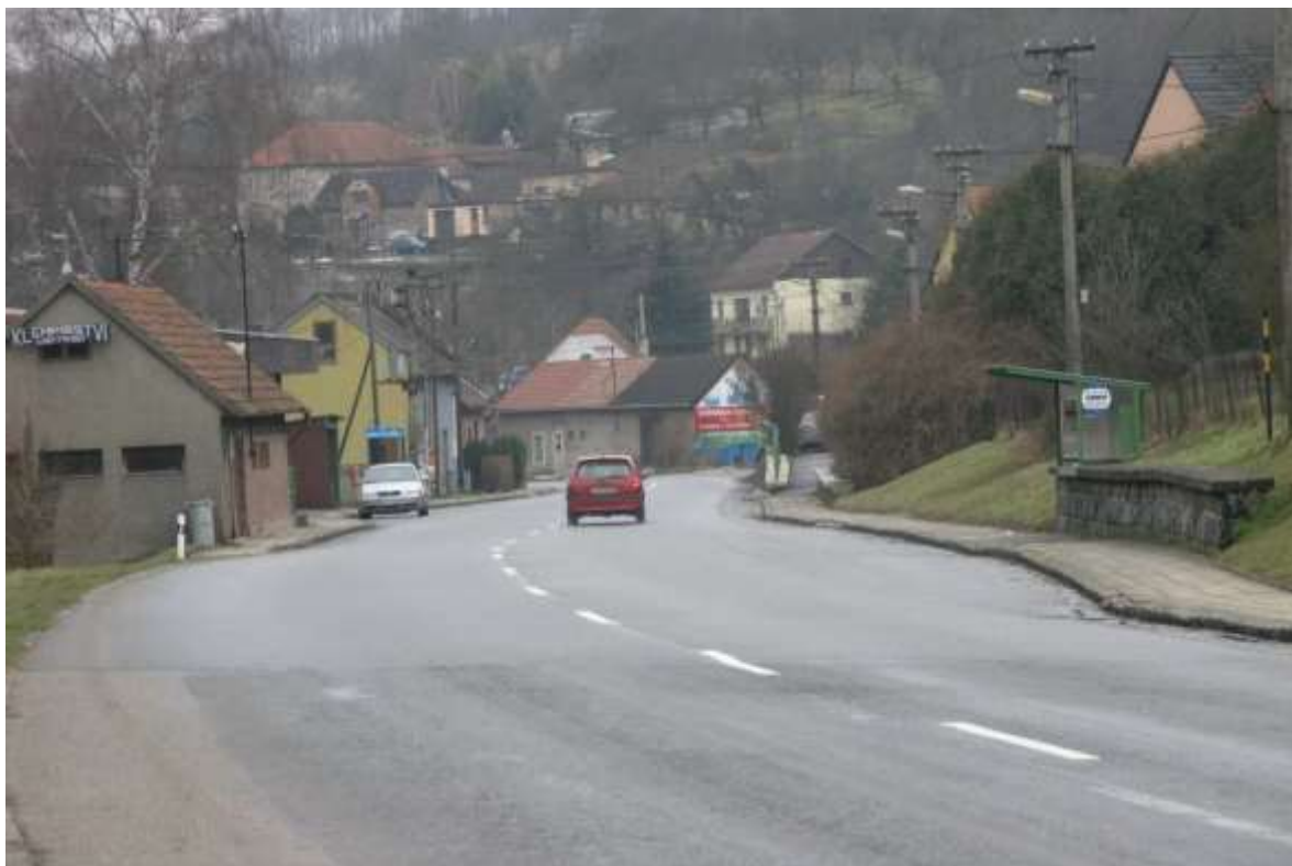
OBRÁZEK 183 POHLED NA CESTU 497, ÚSTŘEDNÍ TEPNA VESNICE. (FOTO JAN AMBRŮZ)
