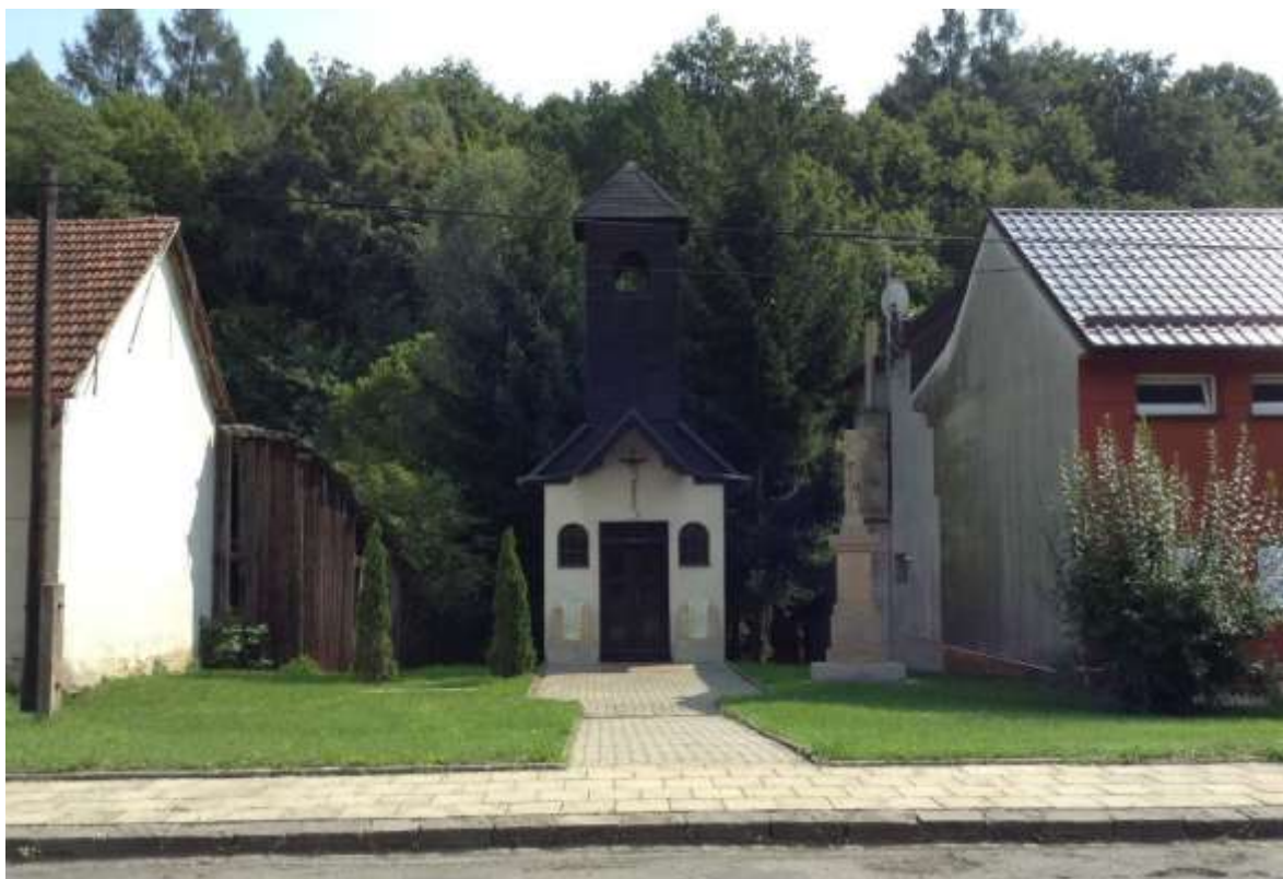
OBRÁZEK 48 POHLED NA KAPLIČKU ČERVENEC 2013, (FOTO JAN AMBRŮZ)
