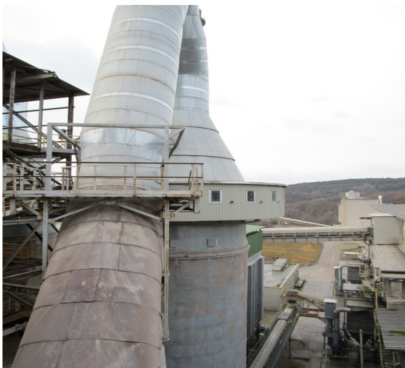
Obr. 10: Spalinovod směřující do sprchového chladiče (kondicionéru); v oblasti tohoto spalinovodu by došlo k paralelnímu napojení výměníku
