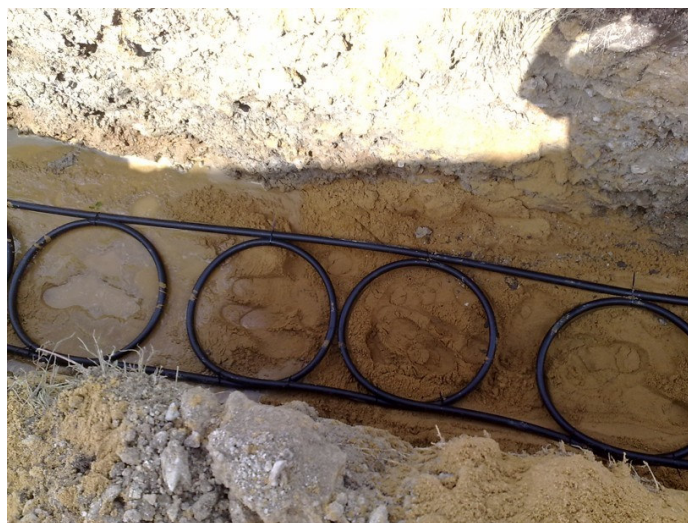
Obr.3.4: Kolektor typu slinky [32].
