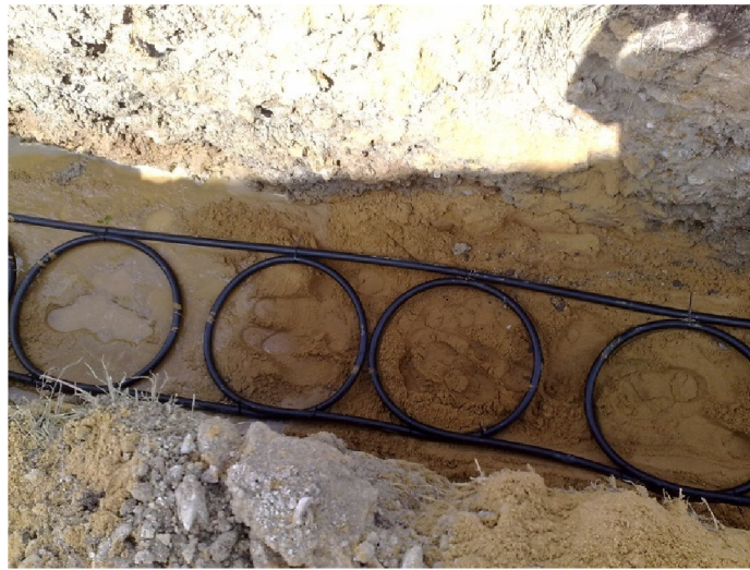
Obr.3.4: Kolektor typu slinky [32].
