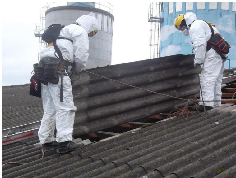
Obr. č. 6: Odstraňování azbestové krytiny
