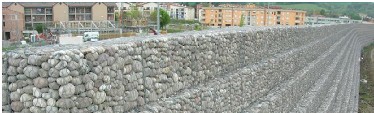
Obr. č. 5: Protihluková stěna z recyklovaného kameniva
