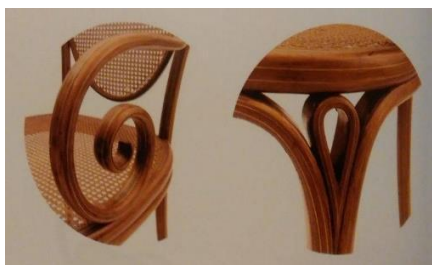
Obr. 11 Detail područky křesla a spojení předních noh se sedákem s mosaznými pásky
