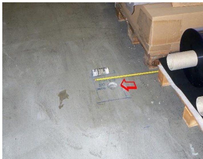
Obr. 4.16 Místo sondy M1V5 do desky ve stropu nad 1. NP
