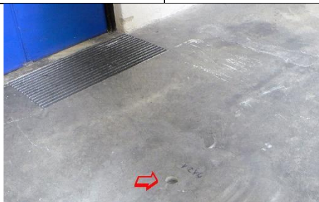
Obr. 8.18 Místo sondy M2V4 do žebra ve stropu nad 2. NP
