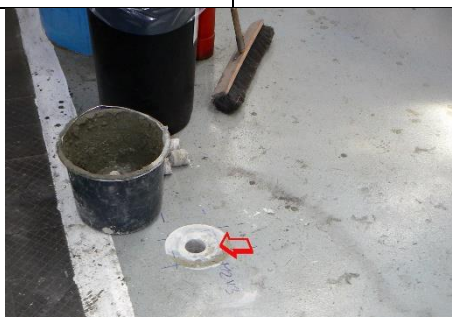
Obr. 8.16 Místo sondy M2V3 do žebra ve stropu nad 2. NP
