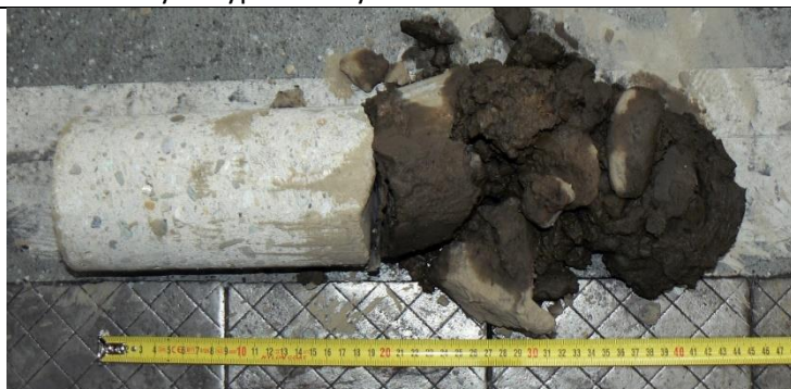
Obr. 8.6 Jádrový vývrt v místě sondy HV2 o průměru 100 mm a délce přibližně 500 mm
