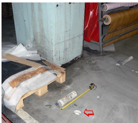
Obr. 4.14 Místo sondy M1V3 do žebra ve stropu nad 1. NP
