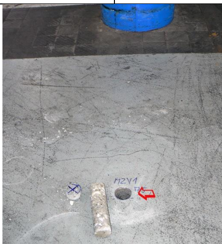
Obr. 8.12 Místo sondy M2V1 do průvlnaku ve stropu nad 2. NP
