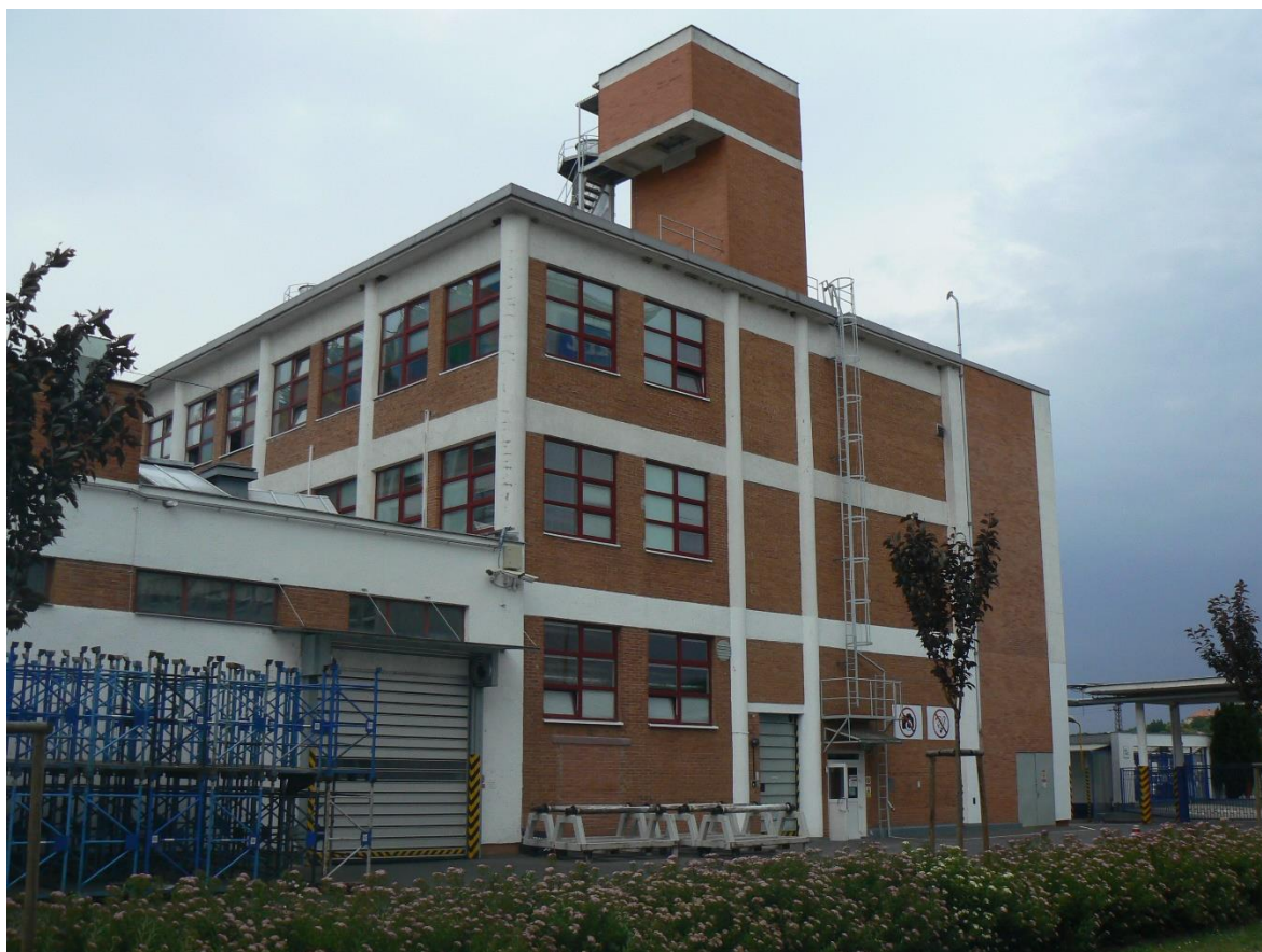
Obr. 4.2 Pohled na třípodlažní halu objektu č. 24 v areálu Fatra Napajedla
