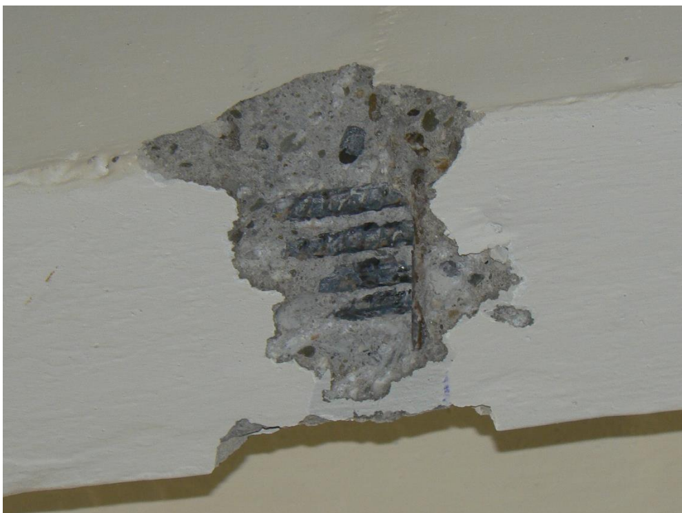
Obr. 3.10 Fotodokumentace sekané sondy žebra
