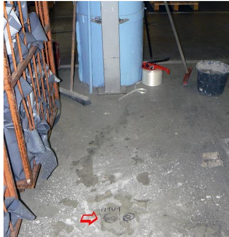
Obr. 4.12 Místo sondy M1V1 do průvlaku ve stropu nad 1. NP
