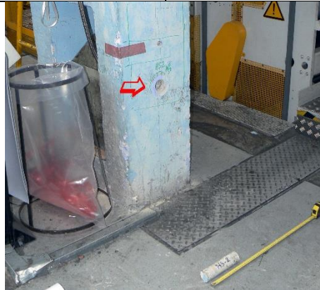
Obr. 8.1 Místo sondy HS2 do sloupu v 1. NP
