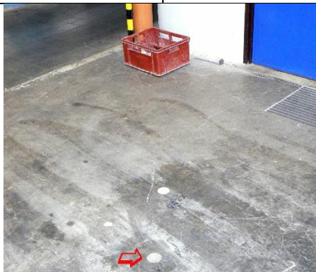
Obr. 8.20 Místo sondy M2V5 do desky ve stropu nad 2. NP
