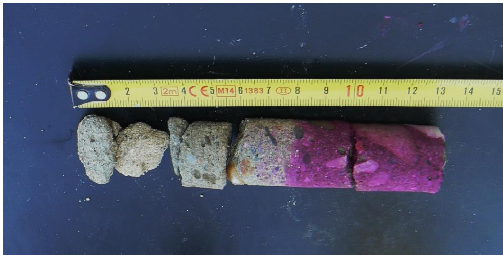
Obr. 3.4 Posouzení hloubky karbonatace
