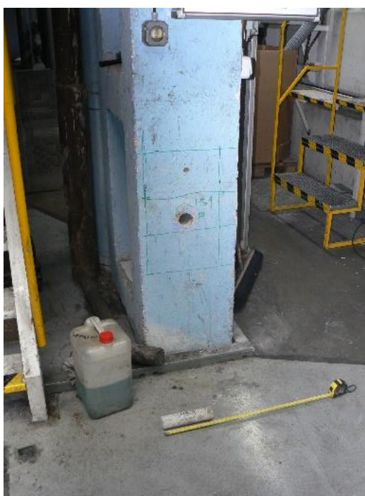
Obr. 4.7 Místo sondy HS1 do sloupu v 1. NP
