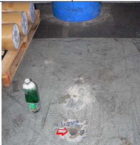
Obr. 8.14 Místo sondy M2V2 do průvlatku ve stropu nad 2. NP
