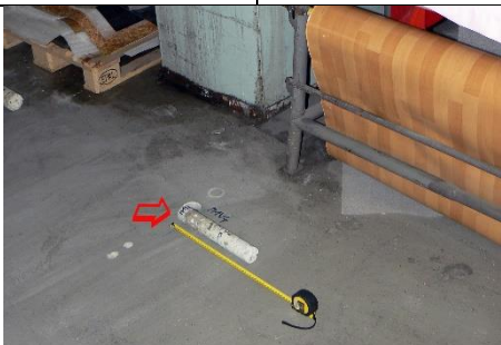
Obr. 8.10 Místo sondy M1V4 do žebra ve stropu nad 1. NP
