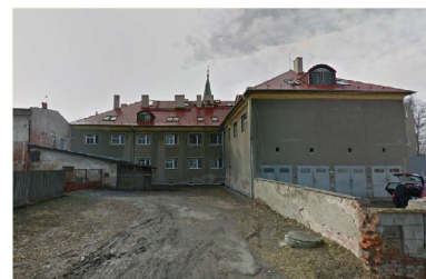
Obr. 1.13: Súčasná podoba budovy, dnes prestavaná na byty
