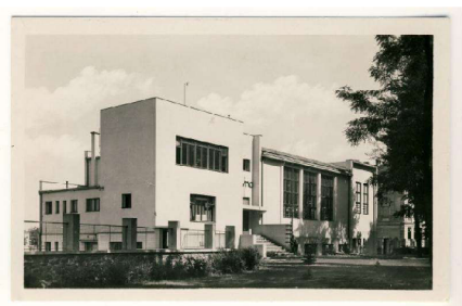
Obr. 1.7: sokolovna; nedatováno funkcionalistická budova litovelské sokolovny postavená v návaznosti na plovárnu a sportovní areál ve 30. letech; slouží organizaci Sokol dodnes
