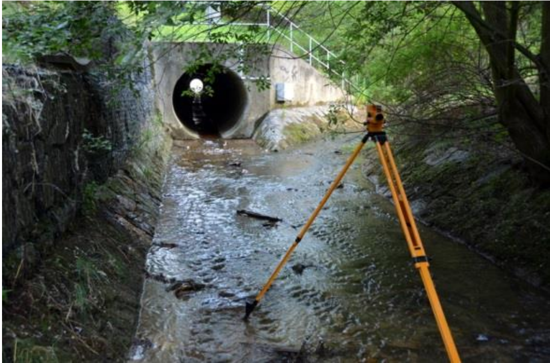
foto č. 21: Výpust' z letiště do Únětického potoka během nivelování
