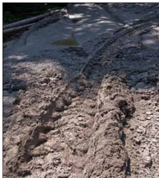
Vliv nepřetržitého nasazení harvestorů (i v deštivém počasí) může vést k výrazným škodám na LDS.
