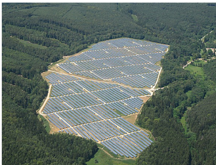
Obrázek 8. Fotovoltaická elektrárna Ralsko Ra 1 [19]
