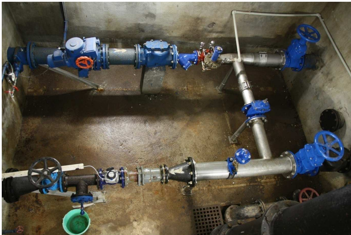
Obr. 3.5 Pohled do armaturní komory
