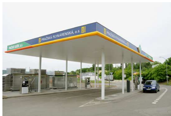
Obr. 14 Plnicí stanice Pražských služeb
