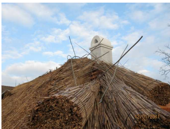
Obrázek 12.1.6: Postupné upevňování
