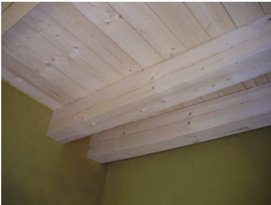
Obrázek 12.2.1: Dřevěný strop se záklopem
