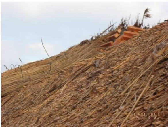
Obrázek 12.1.3: Pokládání prvních vrstev
