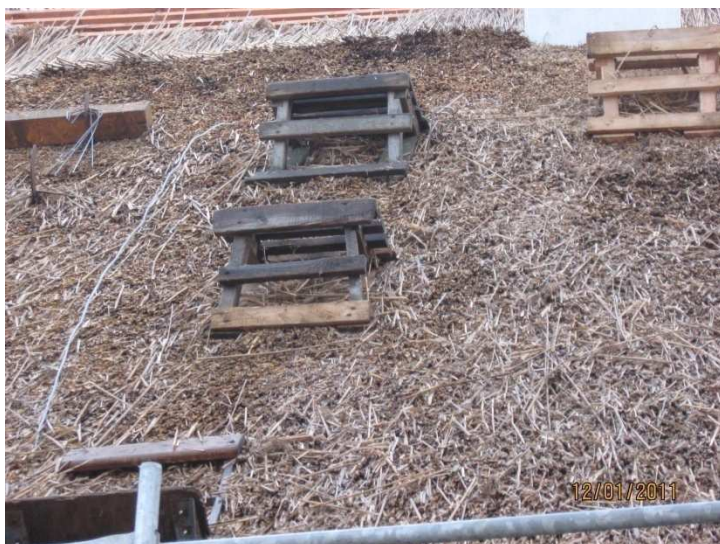
Obrázek 12.1.8: Pomocné plošinky při realizaci
