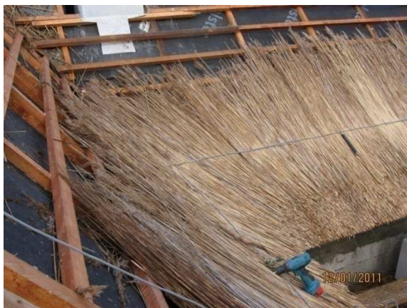
Obrázek 12.1.2: Pokládka první vrstvy
