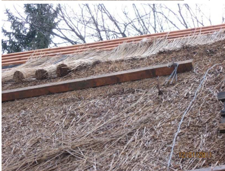
Obrázek 12.1.7: Základní vrstvy bez udusání
