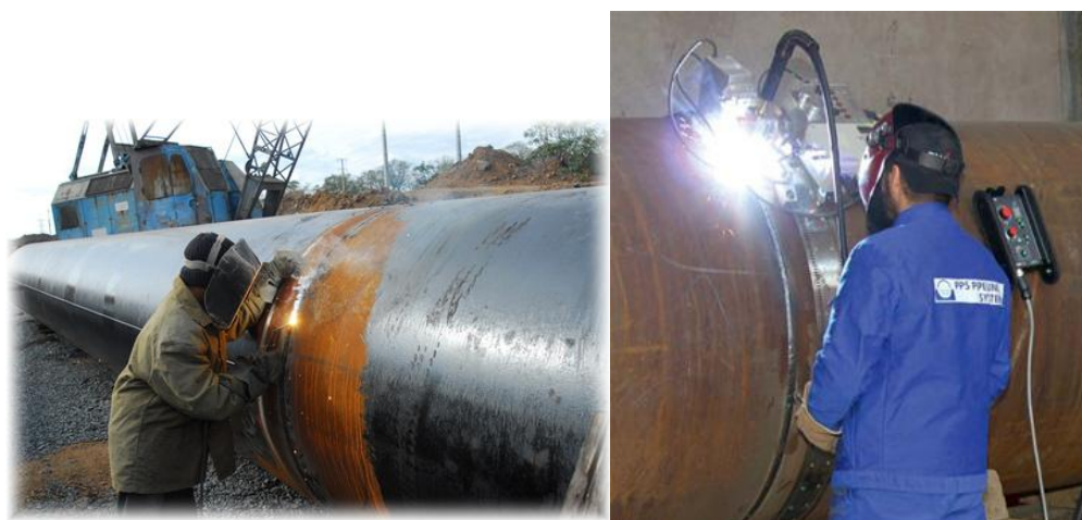
Obr. č. 13 svařování ocelového potrubí a) [20]
