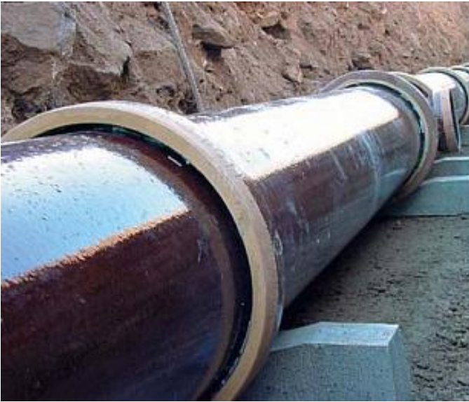
Obr. č. 1: pokládka kameninového potrubí [6]
