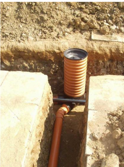
Obr. č. 12 montáž PVC potrubí [19]
