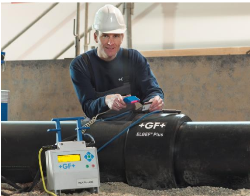
Obr. č. 17 svařování PE potrubí [23]
