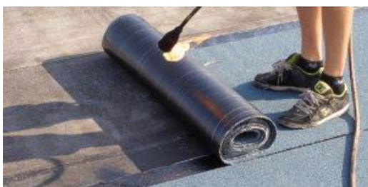
Obrázek 1 - Použití asfaltových hydroizolačních pásů [48]
