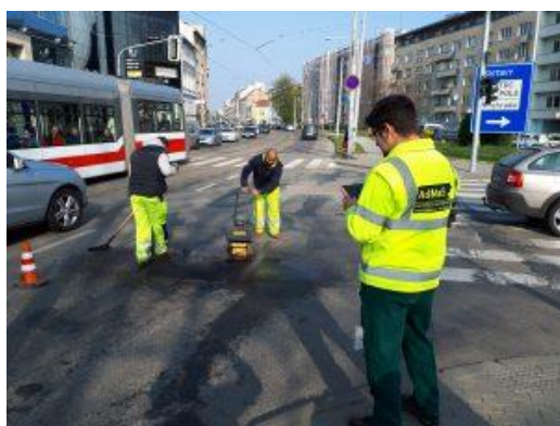
Obrázek 3 - Oprava pozemní komunikace [50]
