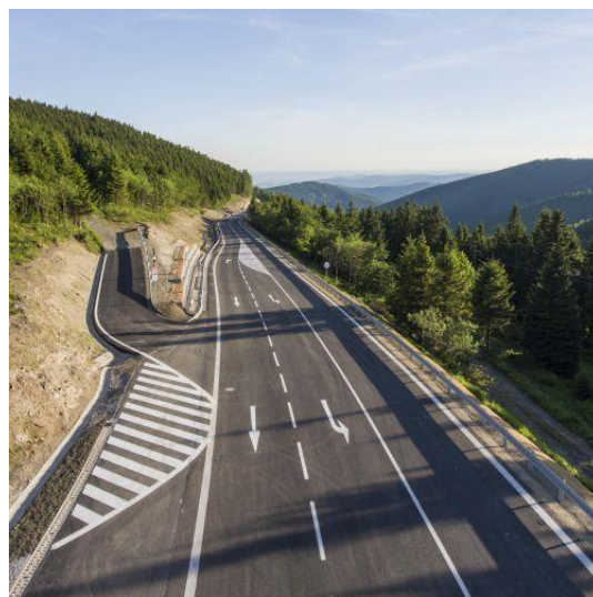
Obrázek 2 - Pozemní komunikace z netuhé vozovky [49]
