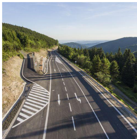
Obrázek 2 - Pozemní komunikace z netuhé vozovky [49]
