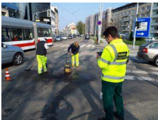
Obrázek 3 - Oprava pozemní komunikace [50]
