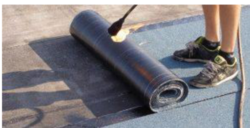
Obrázek 1 - Použití asfaltových hydroizolačních pásů [48]
