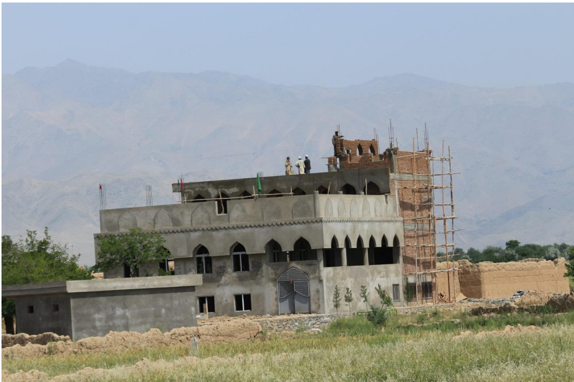
Stavba mešity, zdroj: soukromý archiv autora práce
