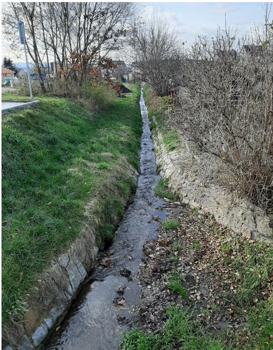
Obrázek 7: Vrátecký potok, úsek č. 5 - Příklad narovnaného koryta se zpevněným dnem i břehy v obci Hlinsko (foto vlastní)
